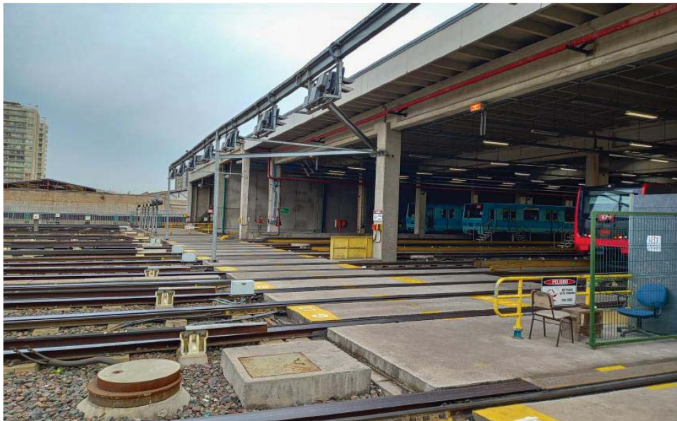
Figura 3. Haz de vías cocheras
