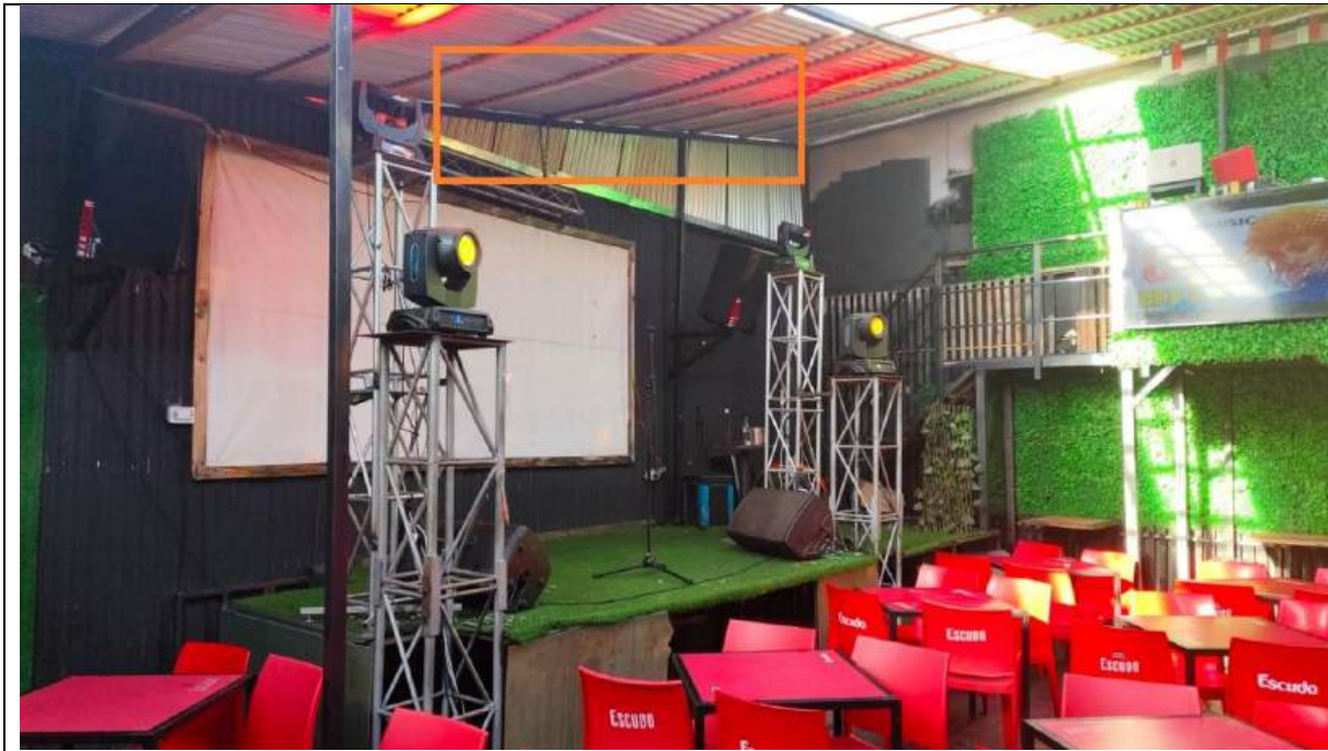
Fotografía actual que acredita el recambio de techumbre en ángulo cerrado
