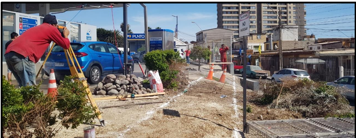
Imagen N° 4. Obtención de niveles.
