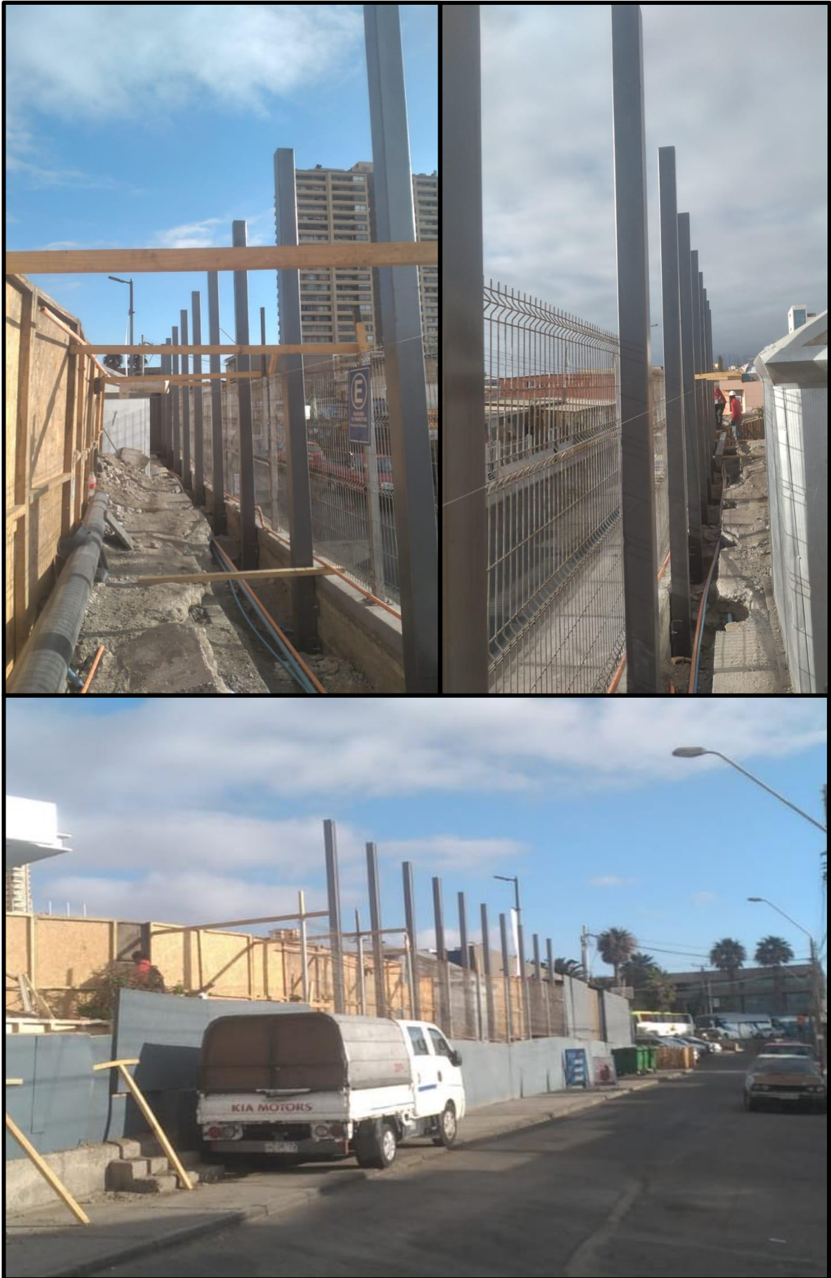
Imagen N° 38. Instalación de pilares.
