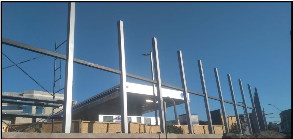
Imagen N° 41. Instalación de pilar transversal.
