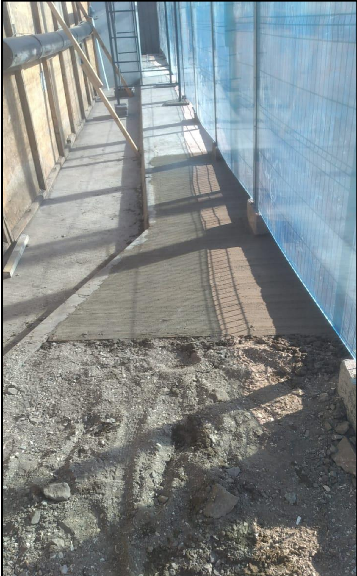
Imagen N° 62. Concretado de área faltante.
