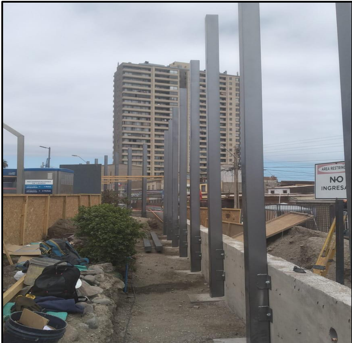
Imagen N° 39. Instalación de platinas a pilares.
