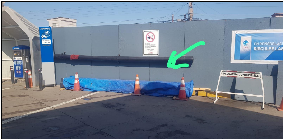
Imagen N° 27. Traslado de pilares a EDS.
