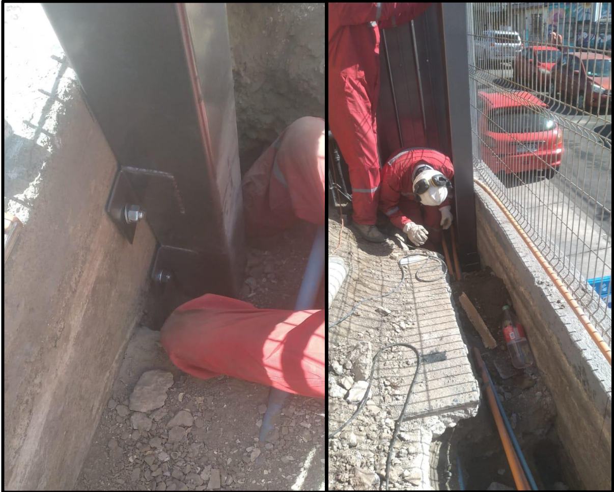
Imagen N° 34. Instalación de pilar.
