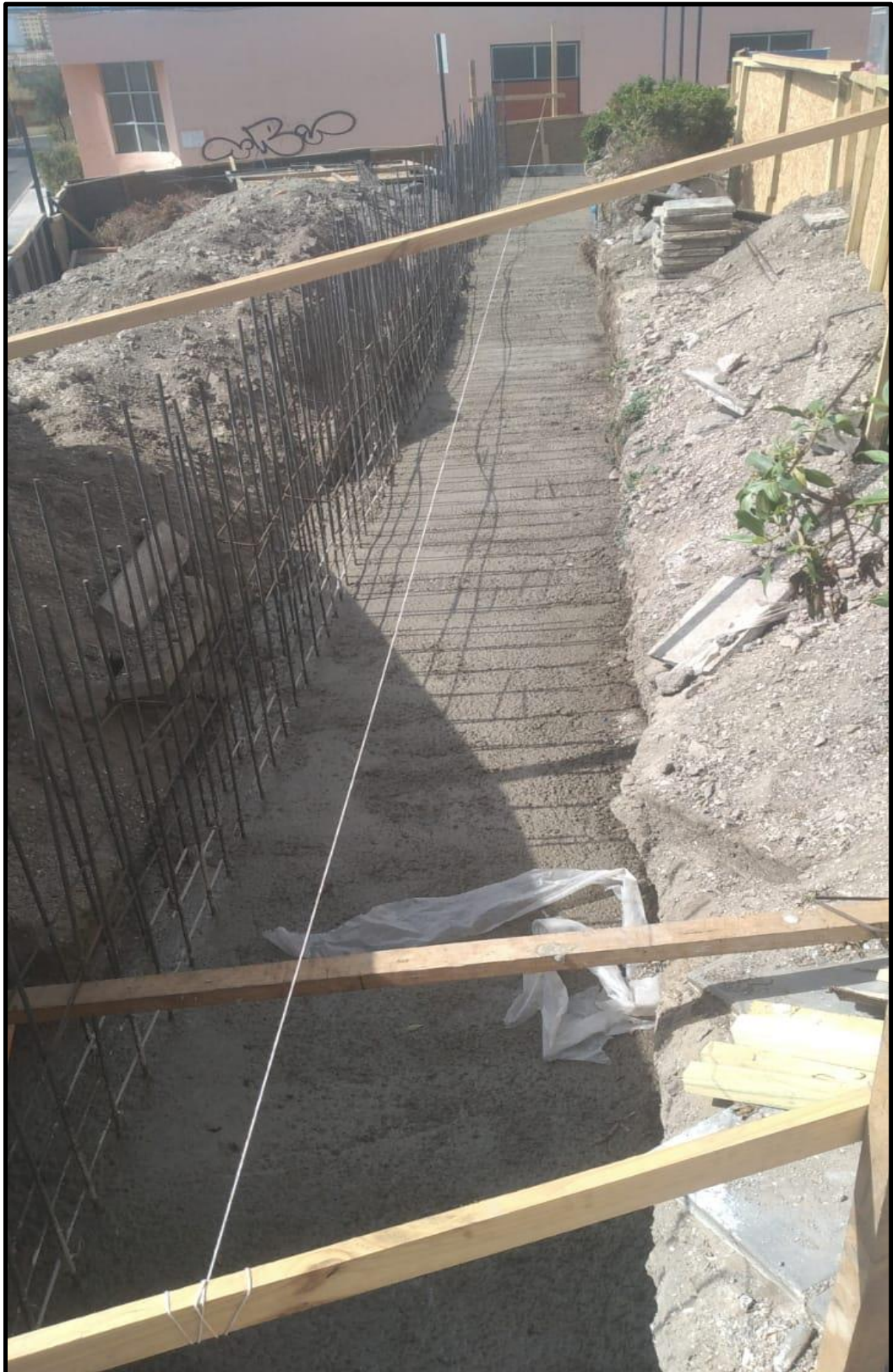
Imagen N° 24. Hormigón cargado queda nivelado.
