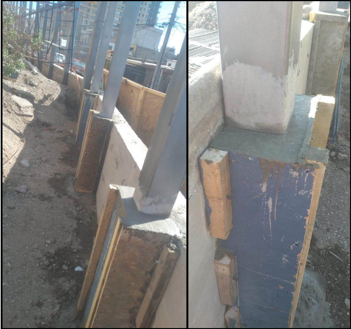
Imagen N° 44. Concretado de cajones.
