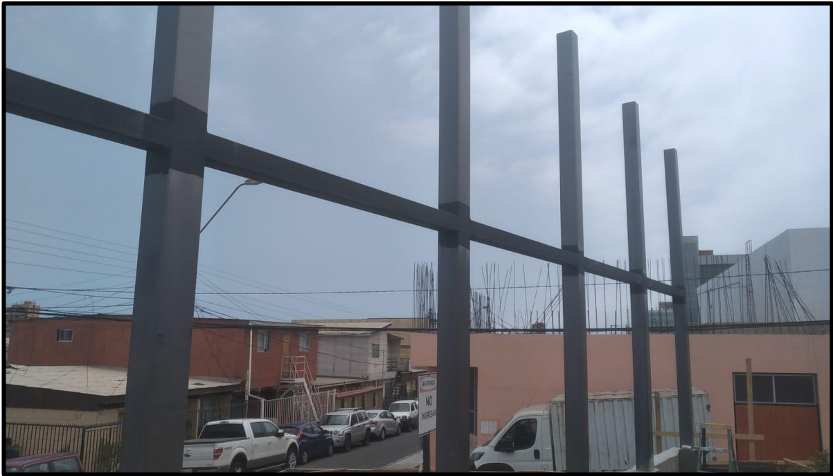
Imagen N° 50. Pintado de unión de pilares con anticorrosivo.
