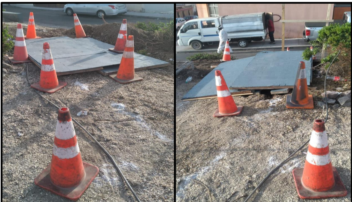
Imagen N° 6. Retiro de EDS. Área excavada queda protegida y señalizada.
