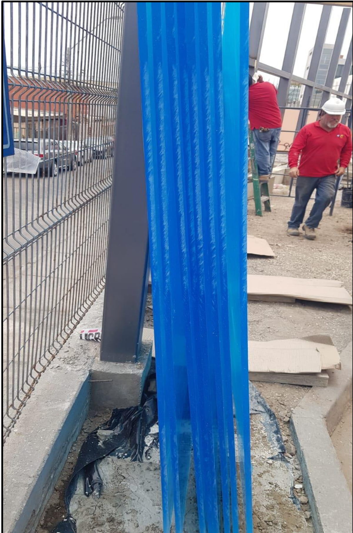
Imagen N° 56. Inicio montaje planchas.
