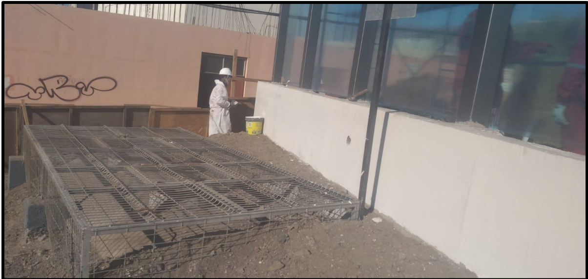
Imagen N° 66. Muro enyesado y empastado.
