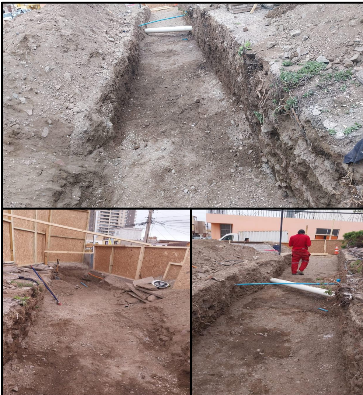
Imagen N° 12. Continuación de zanja.
