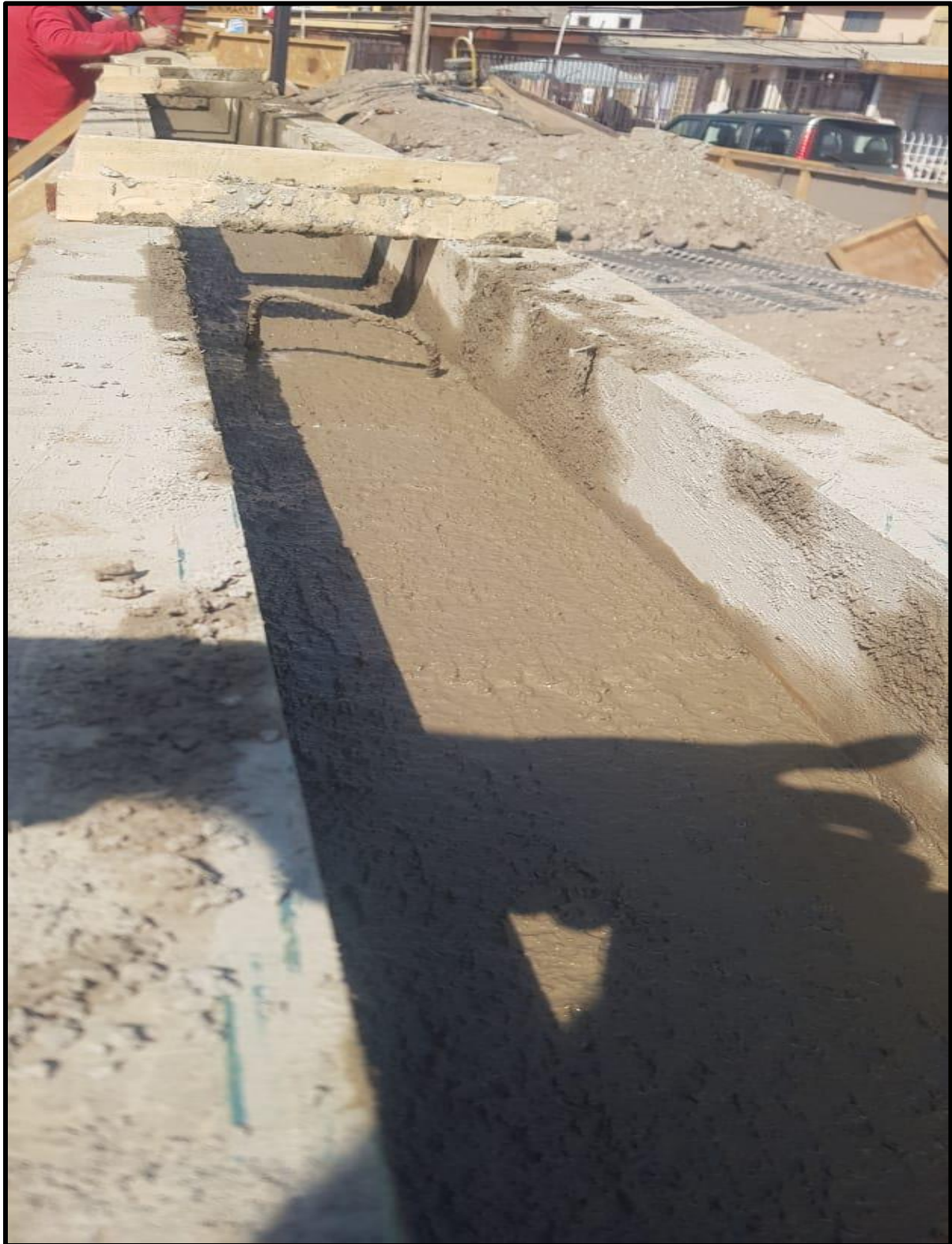
Imagen N° 30. Nivelado de tablero.
