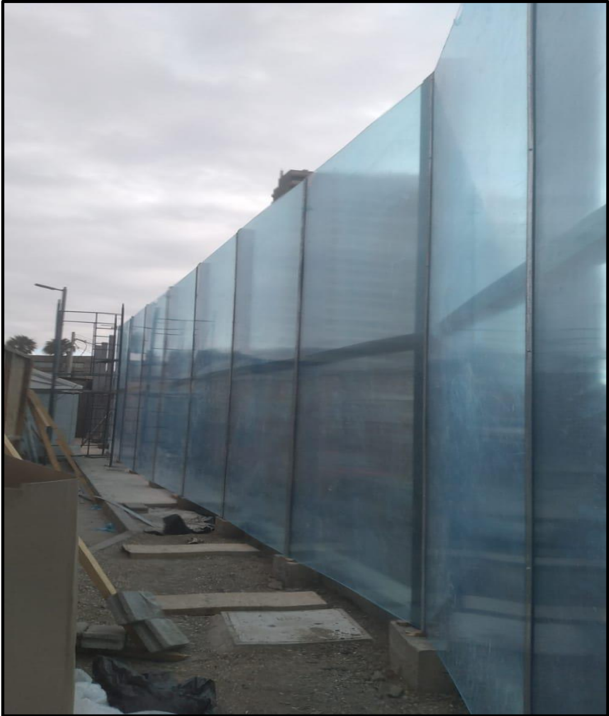
Imagen N° 60. Avance de instalación de planchas.
