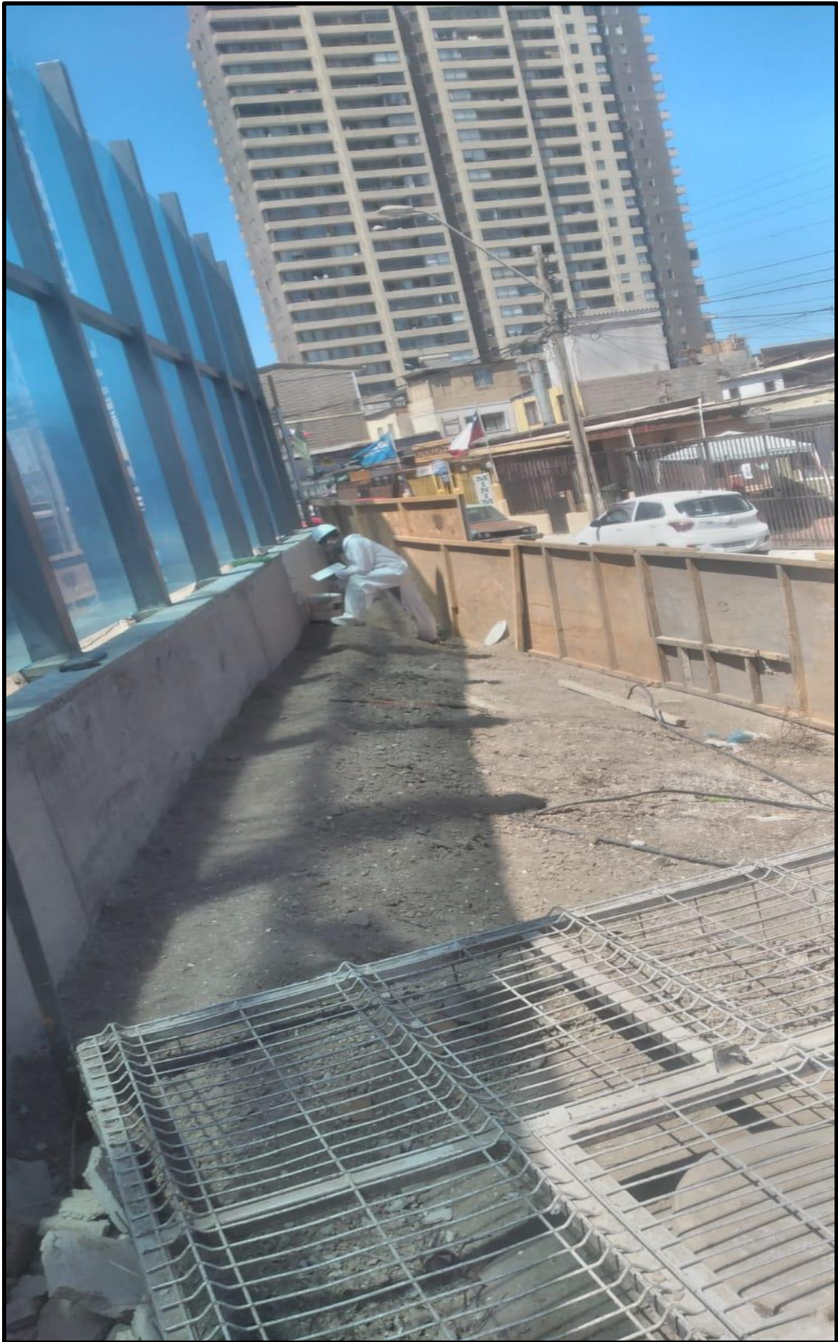
Imagen N° 65. Proceso de empastado y enyesado de muro.
