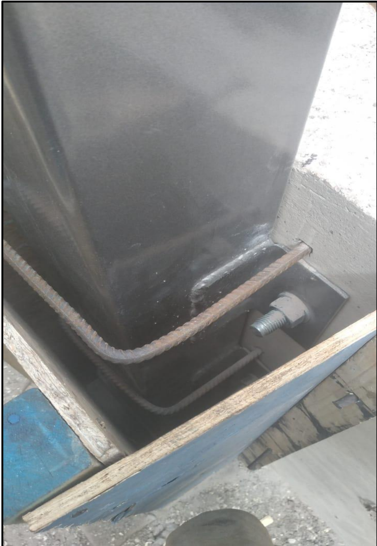
Imagen N° 42. Fijación adicional de pilares.
