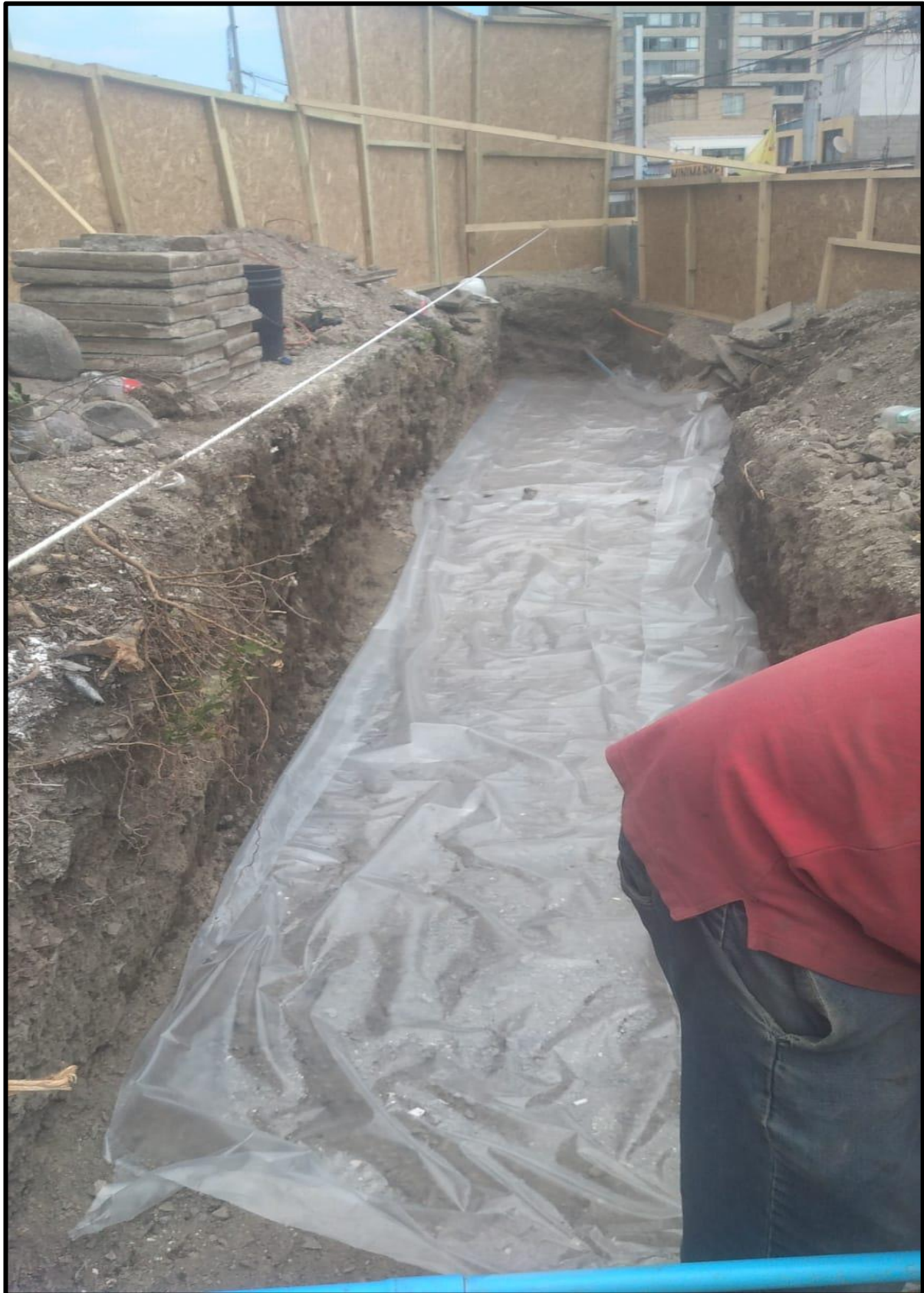
Imagen N° 16. Instalación de polietileno.
