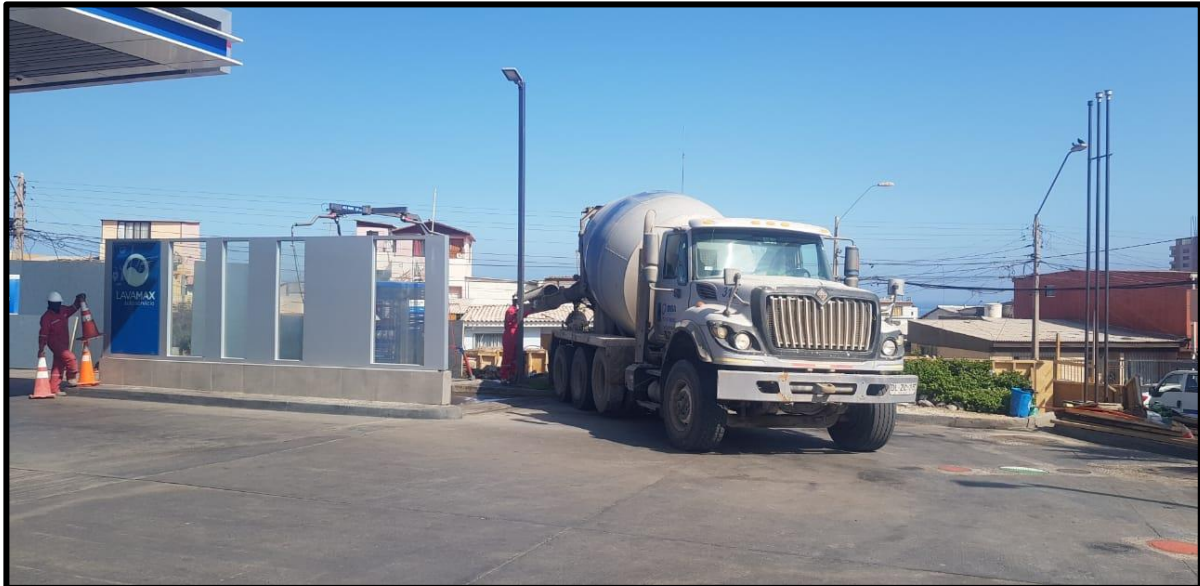
Imagen N° 29. Labores de concretado.
