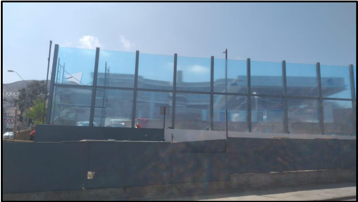
Imagen N° 70. Vista exterior de muro.
