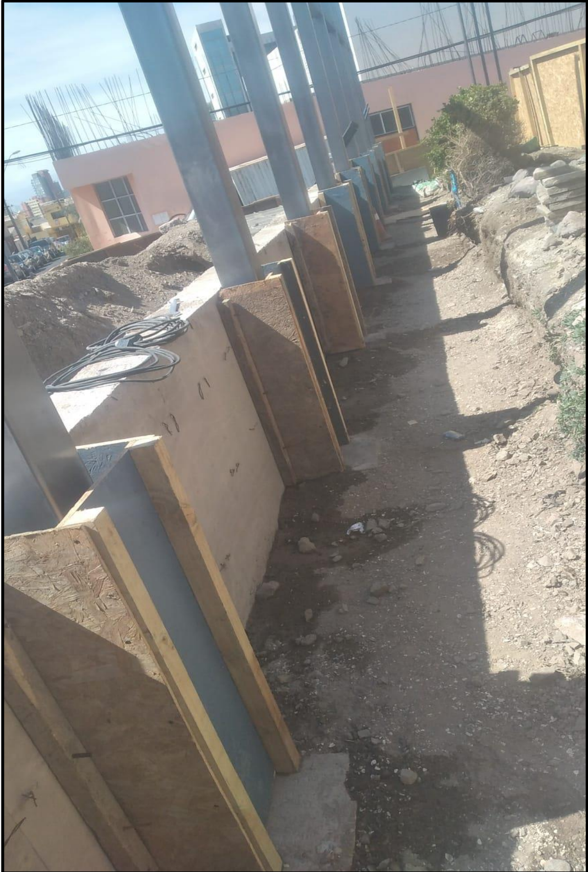
Imagen N° 43. Cajones para pilar y anclados.
