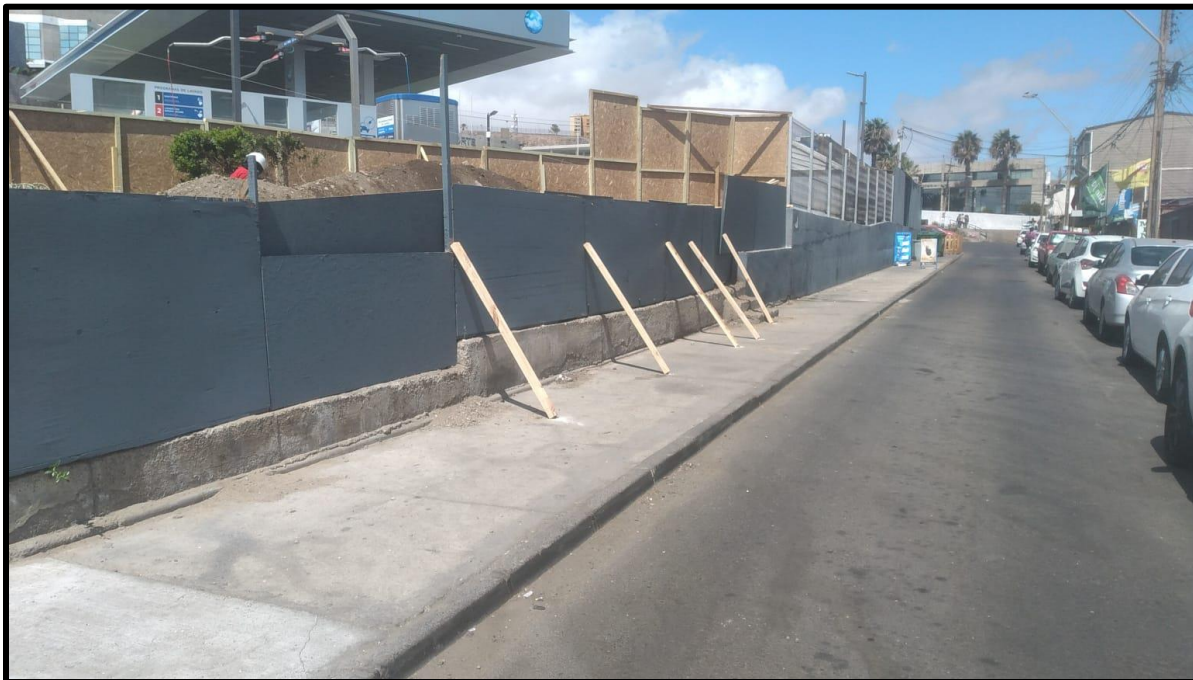
Imagen N° 11. Instalación de puntales con fierro al piso.
