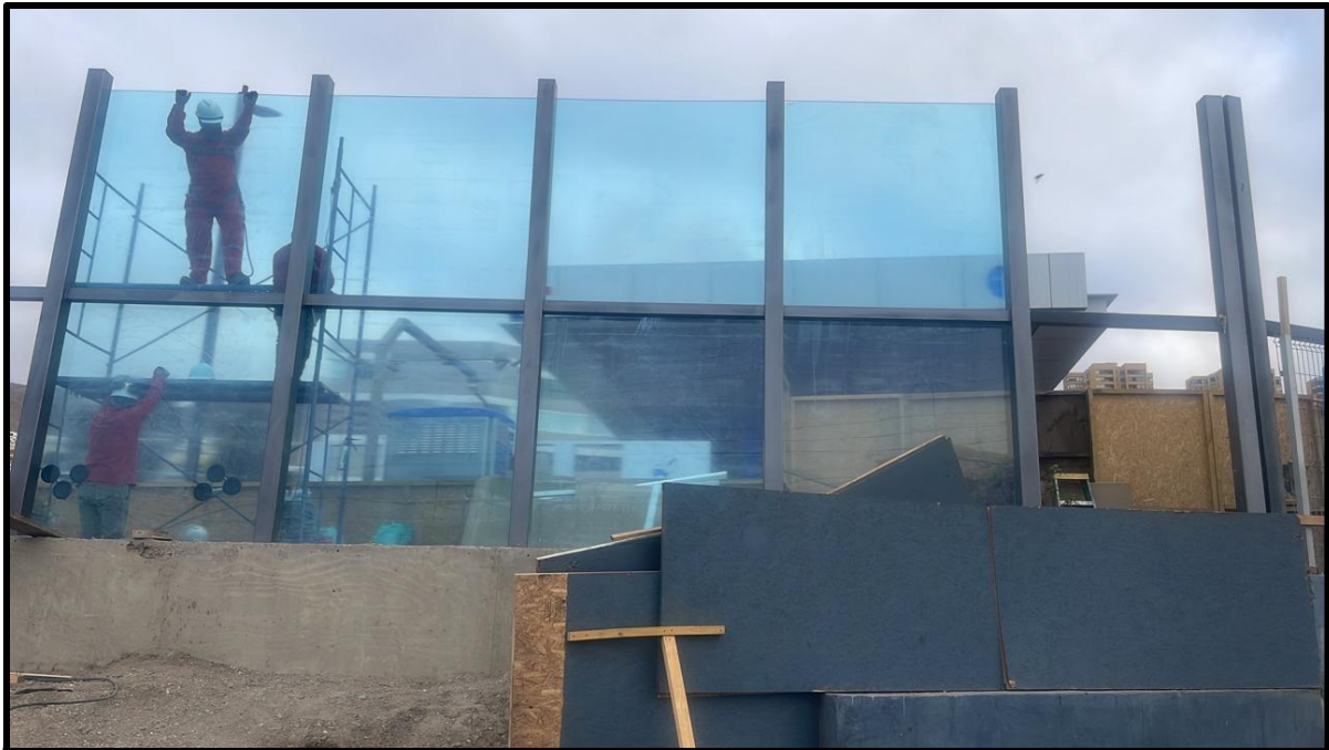
Imagen N° 57. Inicio de instalación de planchas acrílicas.
