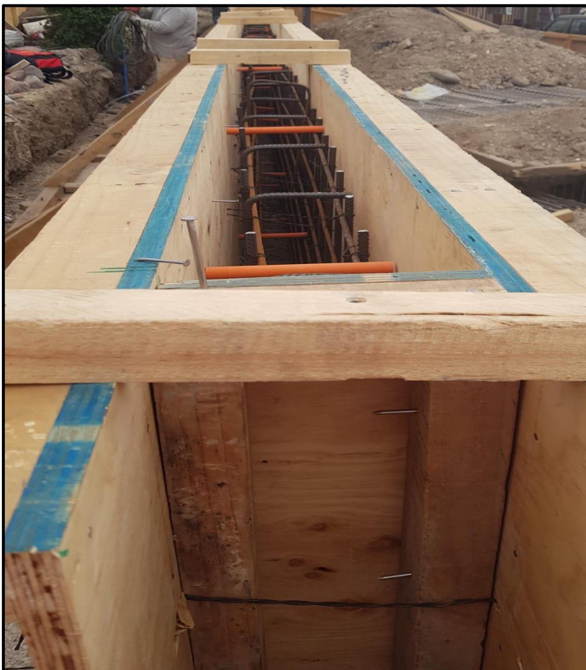
Imagen N° 28. Armado de tablero.
