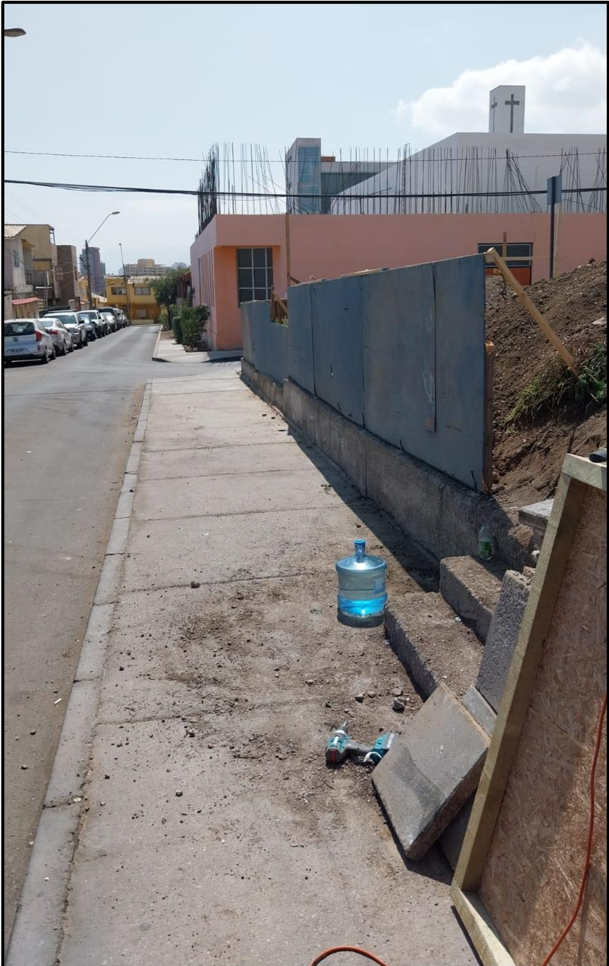
Imagen N° 8. Instalación de paneles perimetrales.
