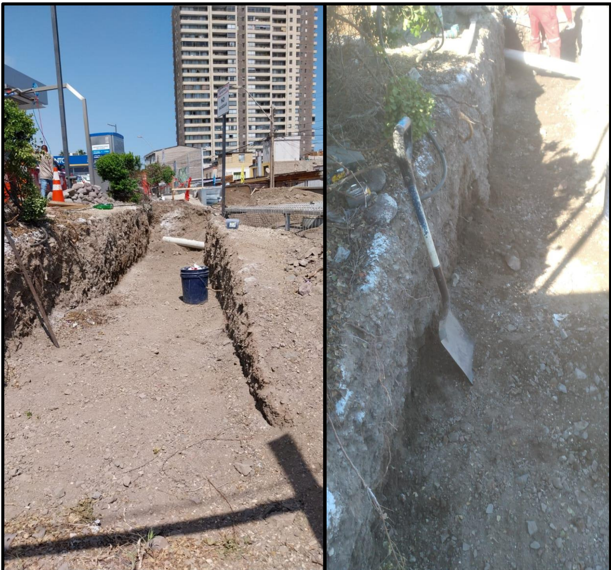
Imagen N° 10. Realización de zanja. Cuadratura para que quede a medida.
