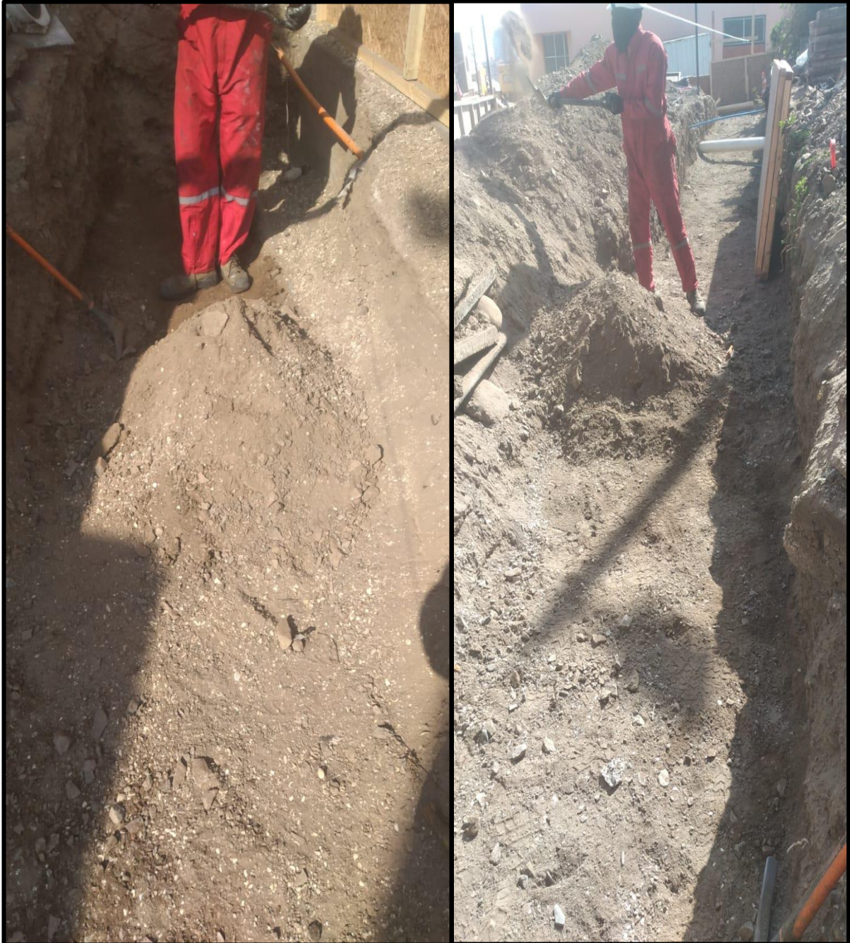
Imagen N° 15. Nivelación de medida.
