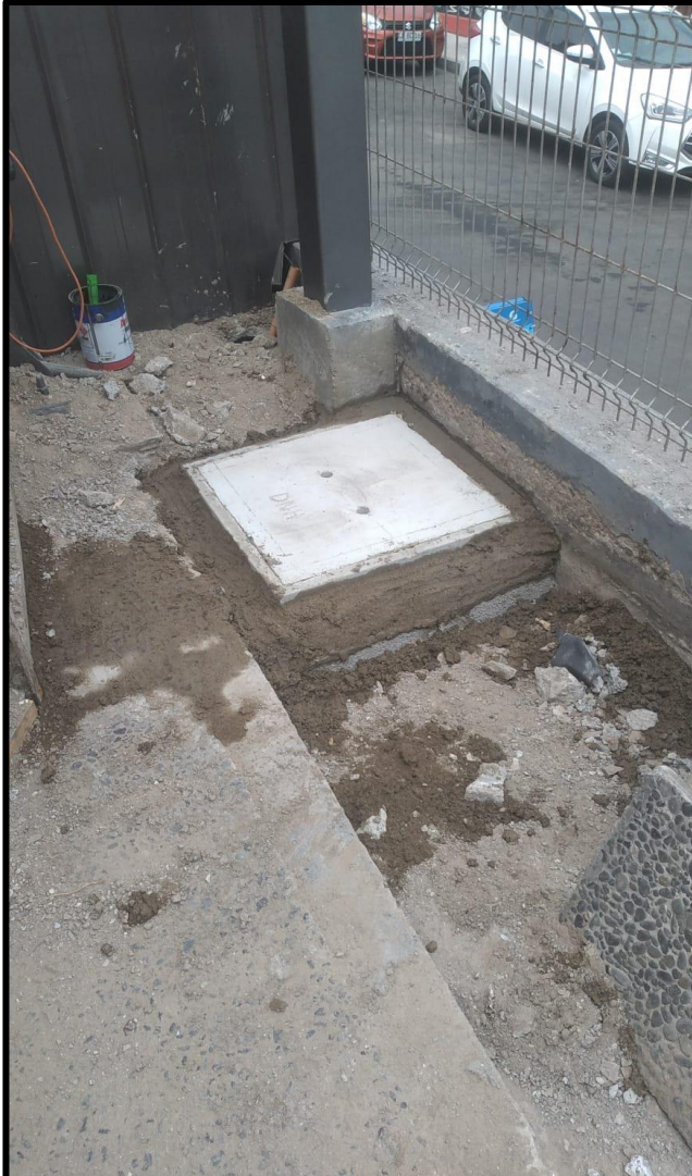
Imagen N° 55. Labor de concretado.
