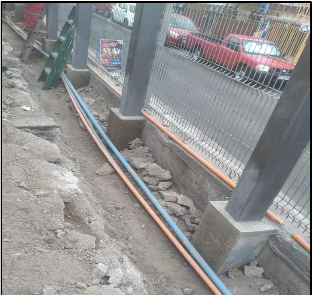
Imagen N° 51. Limpieza de pilares – parte baja.
