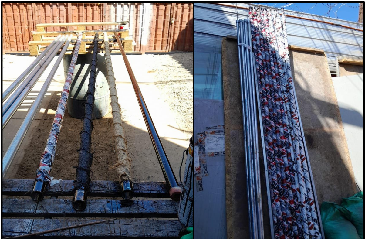
Imagen N° 46. Preparación de cañerías.
