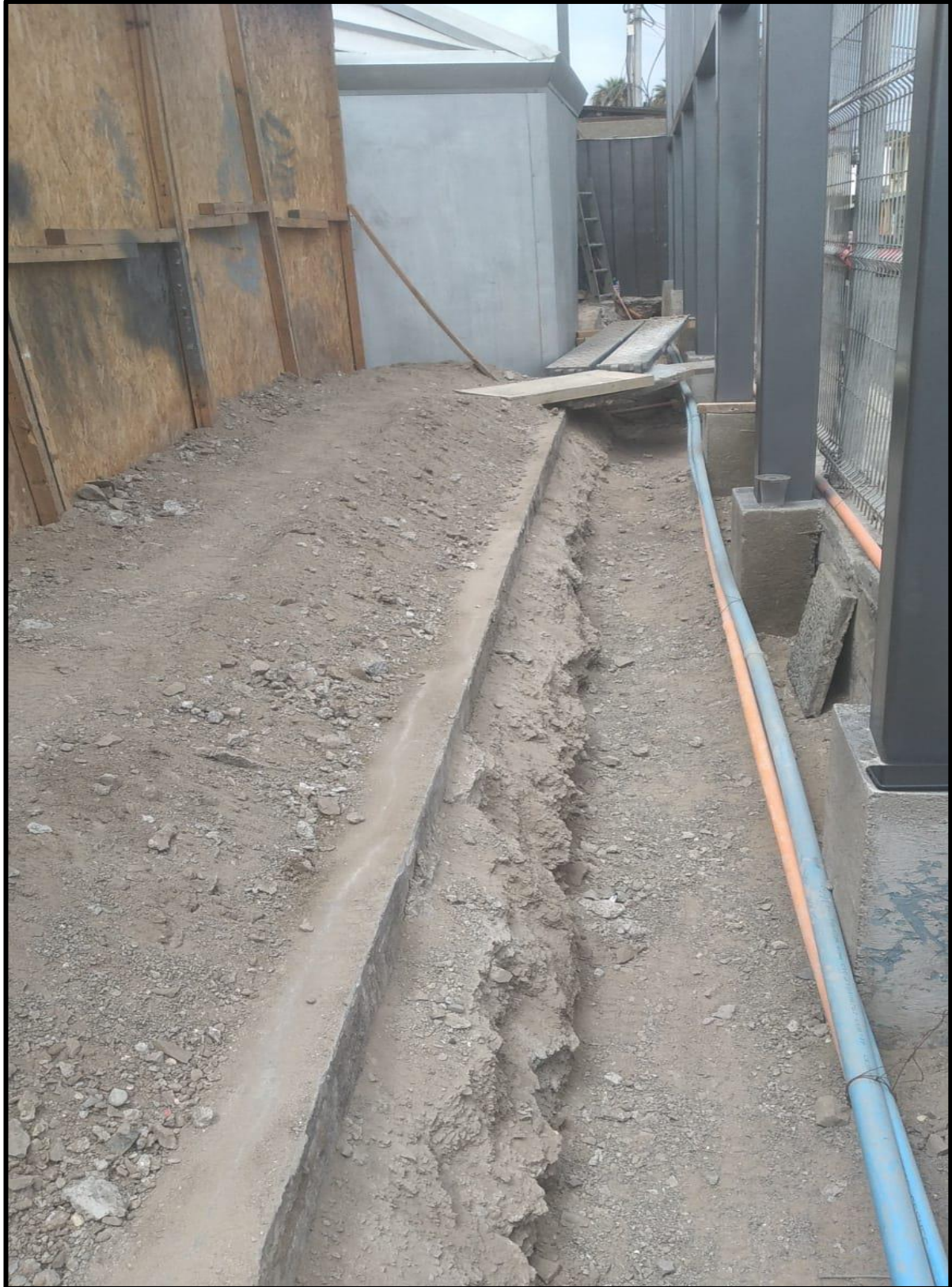
Imagen N° 54. Despeje de área – retiro de piedras.
