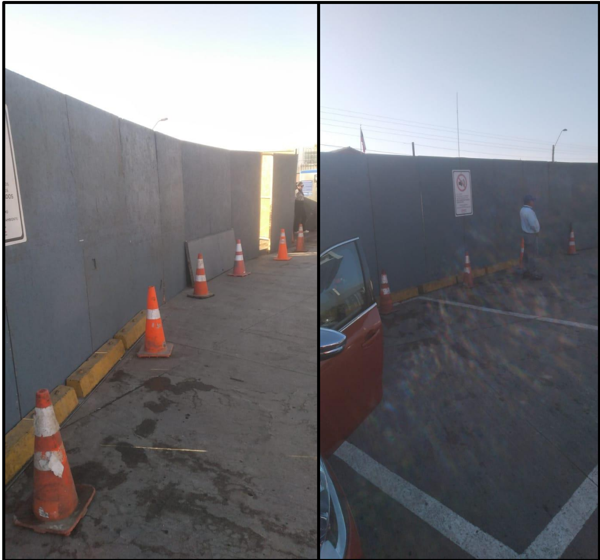
Imagen N° 21. Área queda cerrada con paneles pintados.
