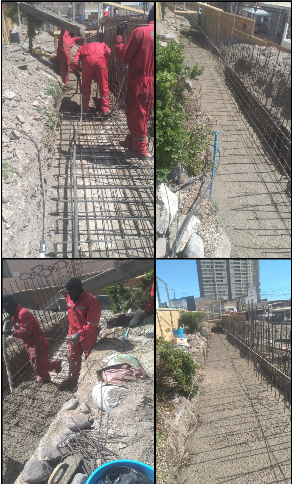
Imagen N° 23. Carga de hormigón.
