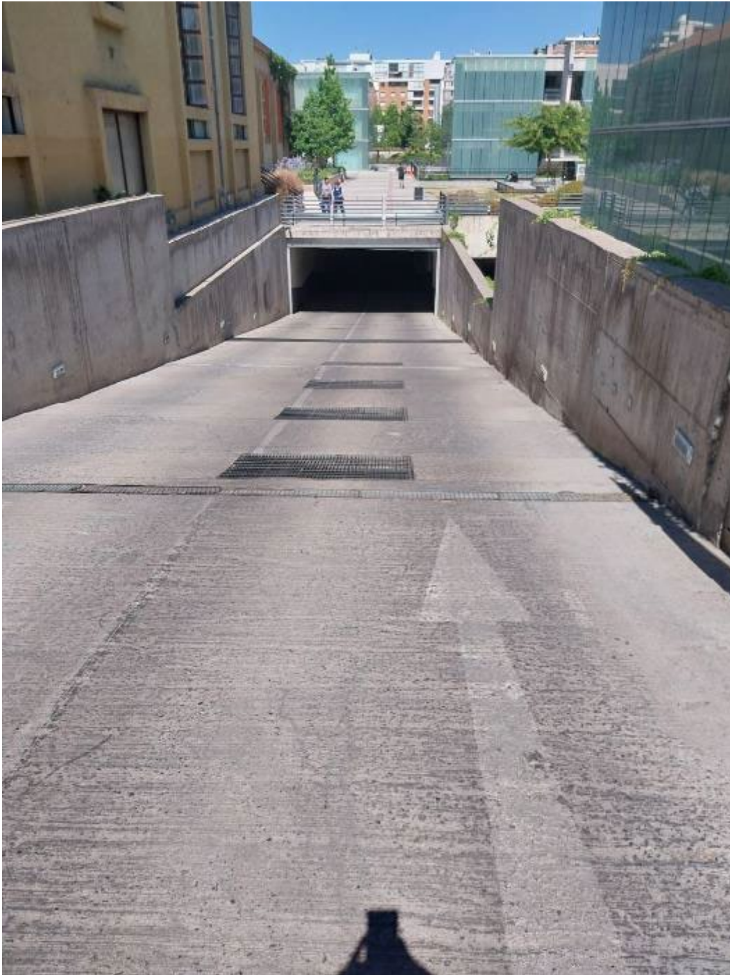
Fotografía N°2 Vista de salidas de aire desde oriente
