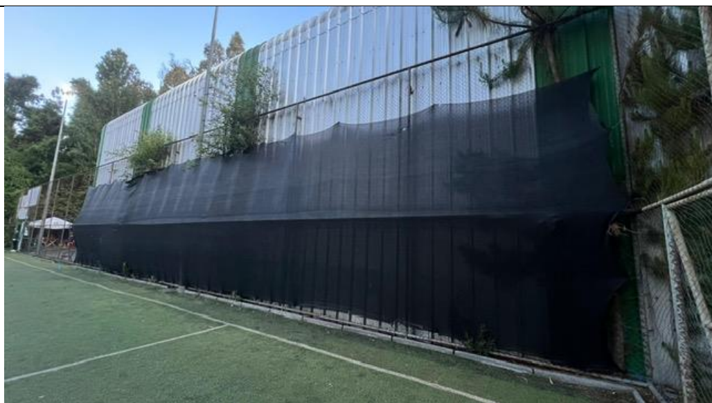
FOTO LATERAL MALLA RACHEL INSTALADA PARA MITIGAR EL RUIDO QUE GENERA EL CONTACTO DEL BALÓN.
