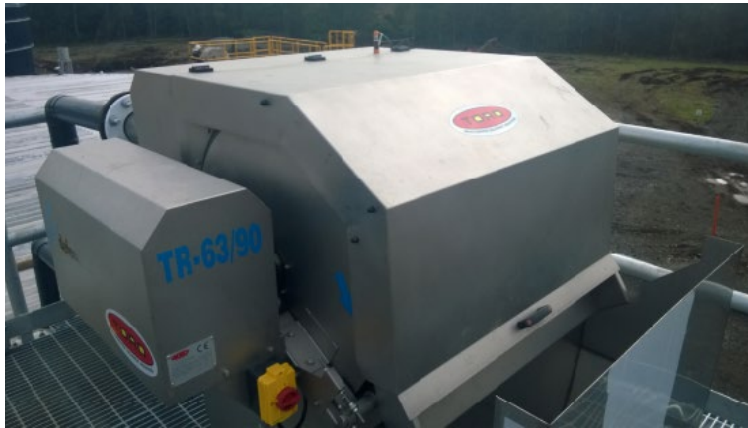
Fotografía 1: Equipo filtro rotatorio de la planta de tratamiento de RILes de Planta Verde
