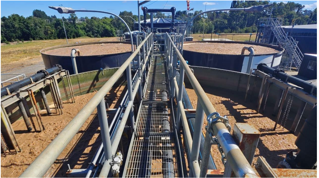
Fotografía 4: Sistema de tratamiento aeróbico de la planta de tratamiento de RILes de Planta Verde
