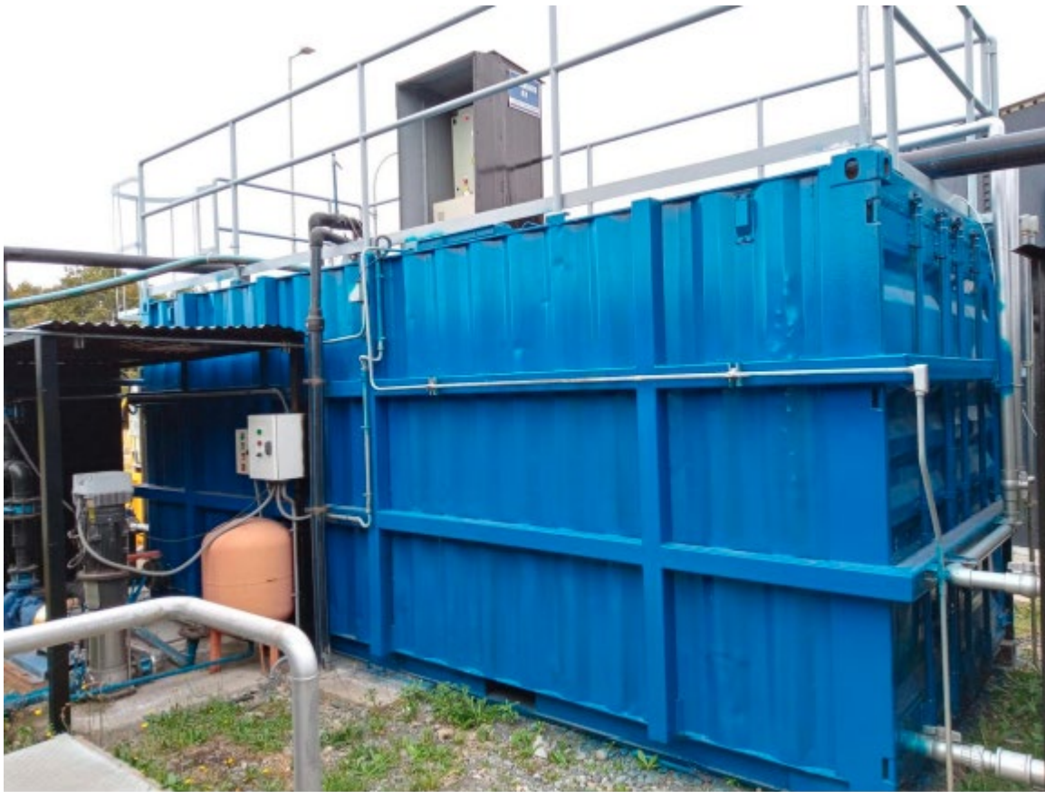
Fotografía 5: Estanque de acumulación del efluente tratado de la planta de tratamiento de RILes de Planta Verde
