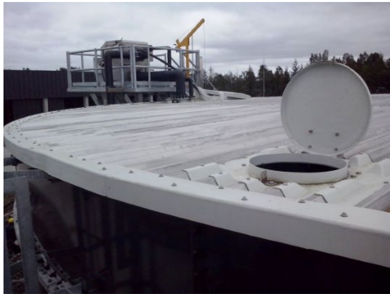
Fotografía 2: Ecualizador de la planta de tratamiento de RILes de Planta Verde
