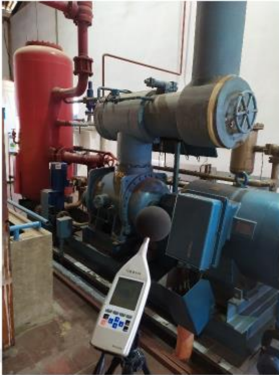
Compresor Tornillo Howden
