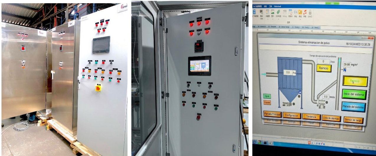
Ilustración 13: Tablero de fuerza y control local GSMI (Imagen referencial).
