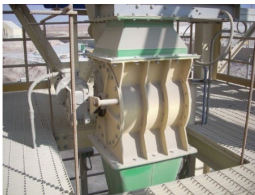
Ilustración 10: Válvula rotatoria (Imagen referencial)
