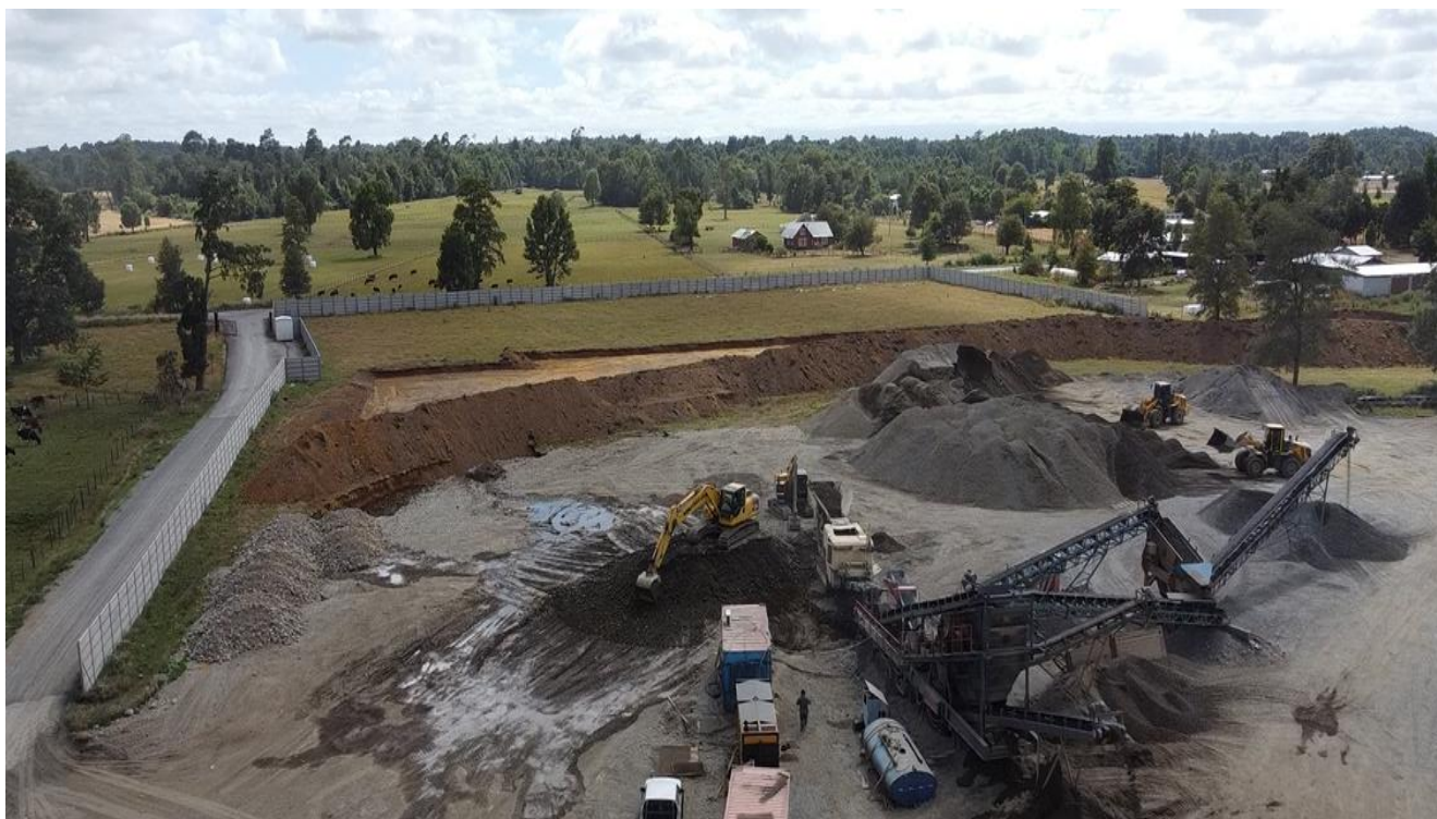
Área de Planta de Producción de áridos y situación a la fecha de 11 de febrero 2025, en donde se evidencia la operación de Planta Chancadora Principal.
