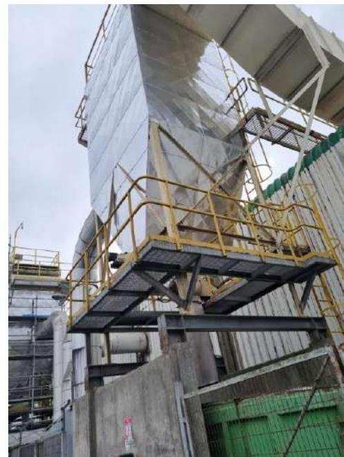
El material utilizado para la aislación acústica fue lana mineral de 100 mm de densidad de 80 kg/m<sup>3</sup> y una cubierta de aluminio de 0,8 mm de espesor.
