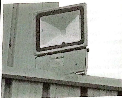
Ilustración N° 7. Luminaria N° 18, tipo LED, 240 V, White, sin información de marca, modelo, potencia u otro (Fotografía 19 IFA).
