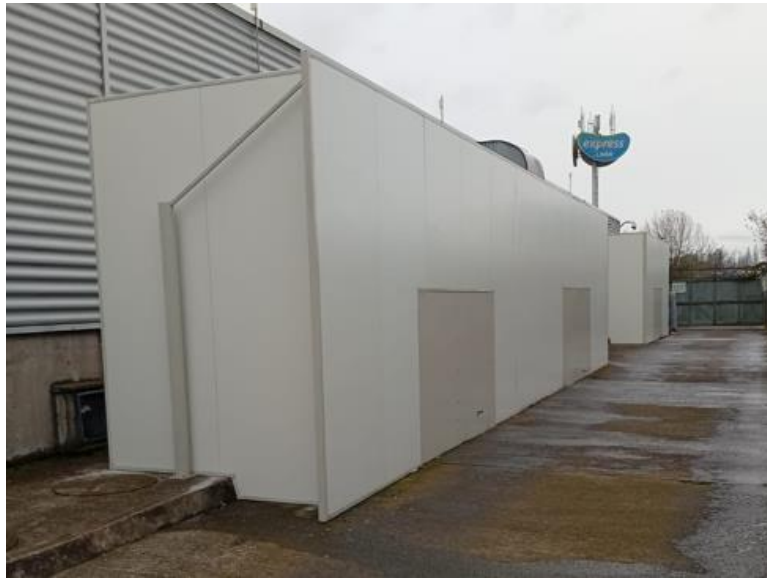
Imagen N°9: Implementación extensión barrera acústica
