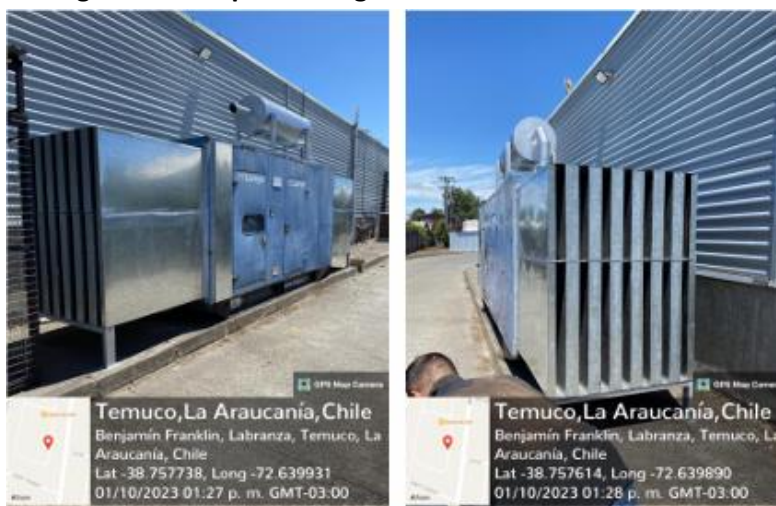
Imagen N°2: Grupo Electrónico con silenciadores instalados
