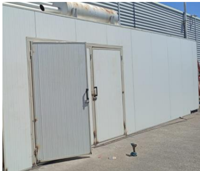
Imagen N°4: Cabina acústica grupo electrógeno más barrera acústica salida de aire
