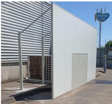
Imagen N°5: Barrera A equipos de clima
