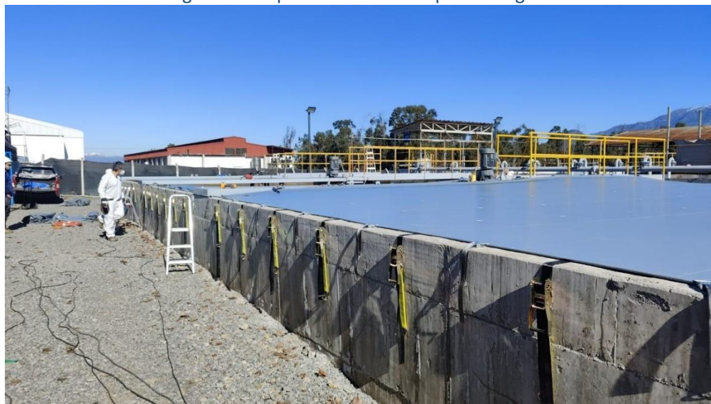
Imagen 4: Encapsulamiento Estanque Homogeneizador
