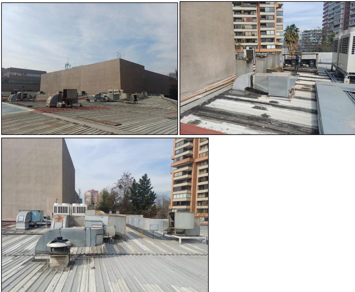
Cine 4 equipos condensadoras y 10 equipos de aire acondicionado compactos.
