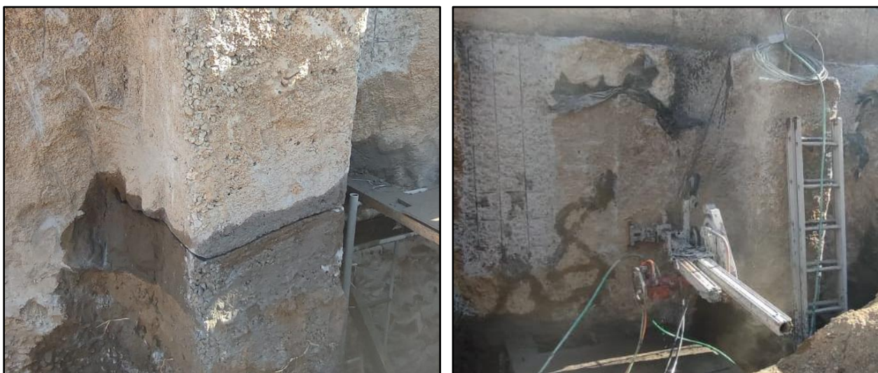
Imagen 2: (izq.) corte horizontal; (Dcha.) corte vertical
