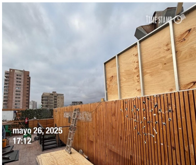
PANTALLA ACUSTICA AUMENTO ALTURA Y CONSTRUCCION MATERIALIDAD ACUSTICA
