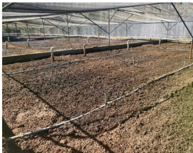
Interior de un módulo Biofiltro
