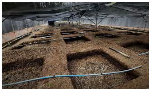
Reemplazo de lecho filtrante
