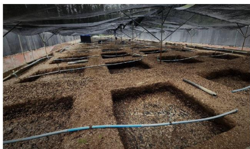
Reemplazo de lecho filtrante
