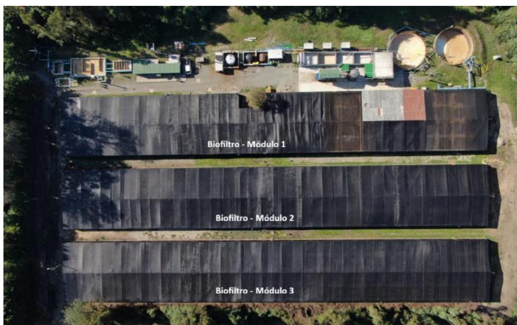
Vista aérea Planta de Riles – Módulos Biofiltro
