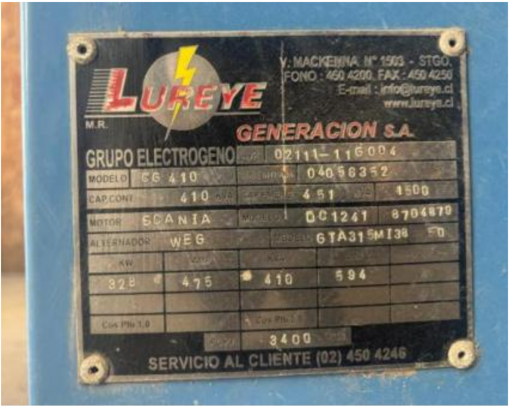
Imagen N°1: Características grupo electrógeno.
