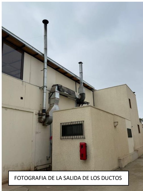
FOTOGRAFIA EXTRACTOR CENTRÍFUGO MODELO CBA-BA-400
