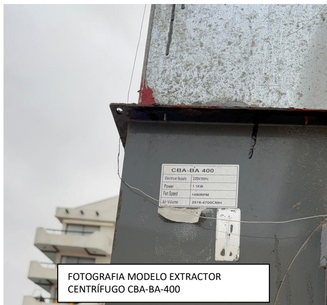
FOTOGRAFIA EXTRACTOR CENTRÍFUGO MODELO CBA-BA-400
