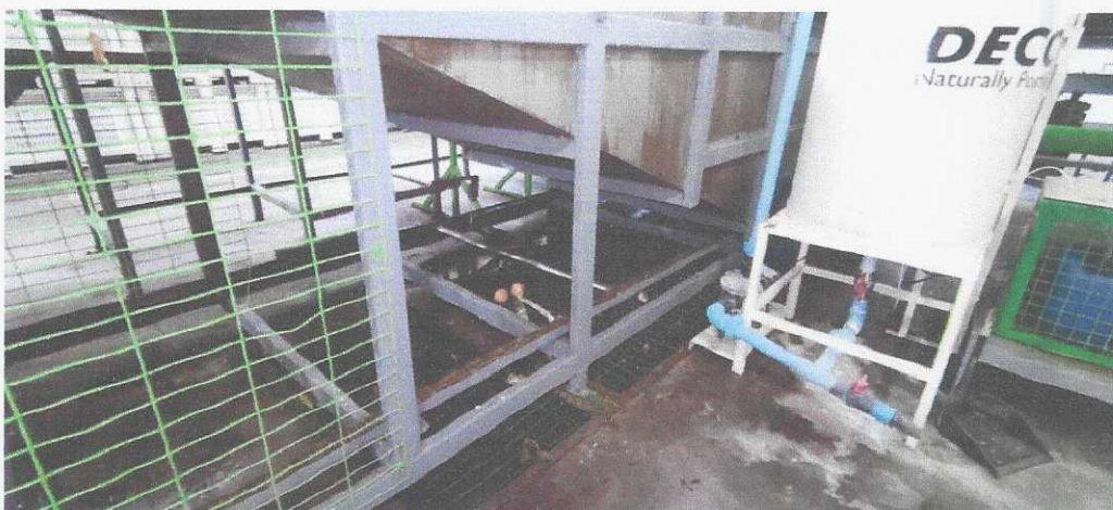
Figura 3: Acumulación de residuos orgánicos en ductos de lavado.
