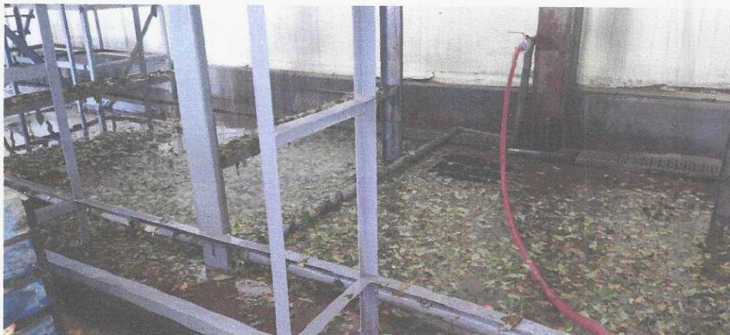
Figura 2: Acumulación de residuos orgánicos en ductos de lavado.
