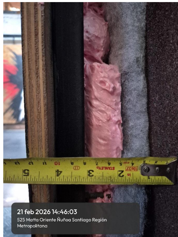
Foto 4-5: "Paneles estructurales de 18mm terminados tras la instalación del material absorbente".
