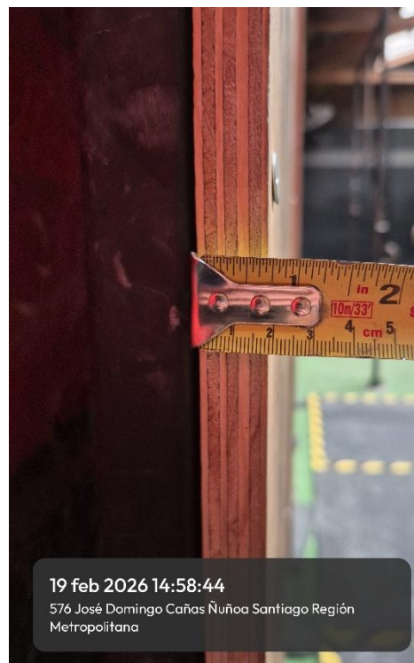
Foto 3 y 4: Paneles estructurales de 18mm antes de la instalación del material absorbente.
