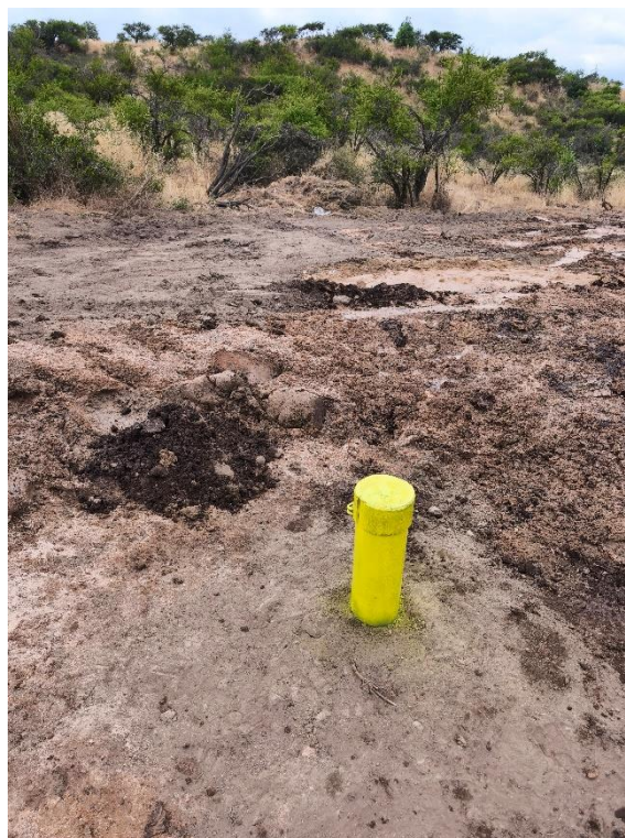
3. Pozo terminado, con tapa de acero y pintura para que sea visible desde vehículos.
