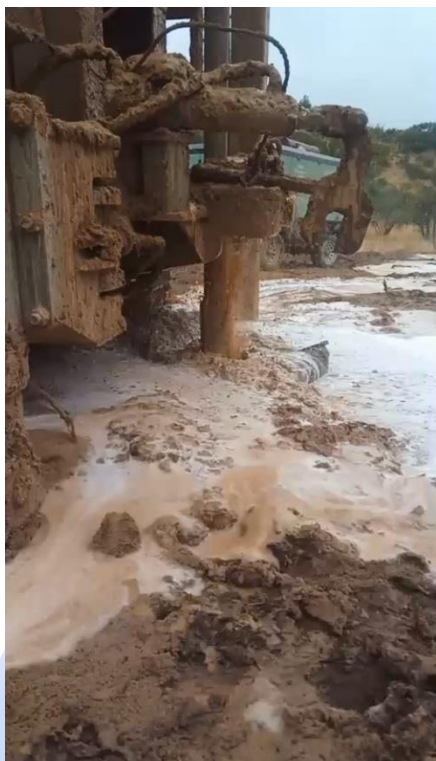
1. Comienzo de Extracción de Agua.
