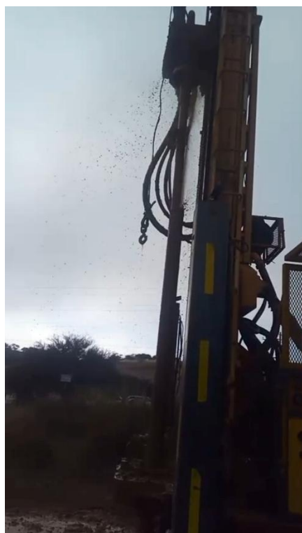
2. Comienzo de Extracción de Agua.
