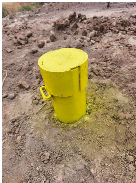
4. Pozo terminado, con tapa de acero y pintura para que sea visible desde vehículos.
