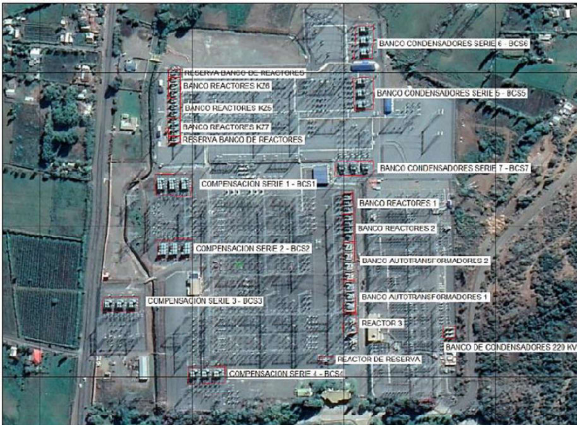
Imagen 1. Emplazamiento del establecimiento “Subestación Ancoa”.
