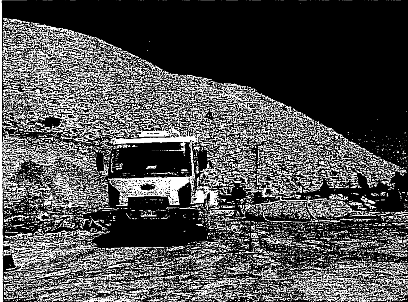
Plataforma en operación.
