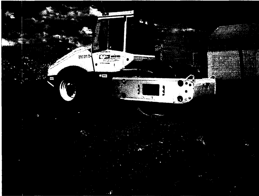
Imagen 9. Nivelación con estabilizado.
