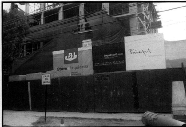
Imagen N° 1.- Vista general durante la construcción
