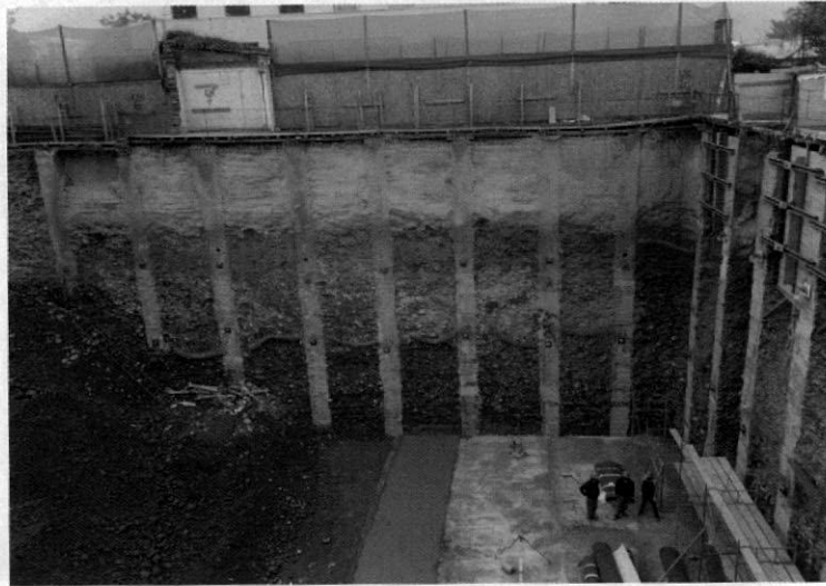
Imagen N° 2.- Vista general de excavación y protecciones a predios vecinos
