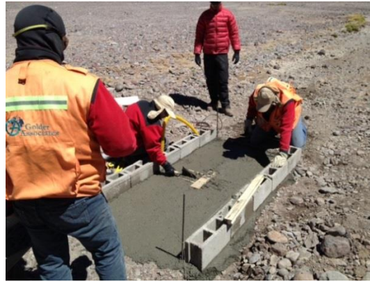
Figura 4: Construcción Estación Fluviométrica EFM-04
