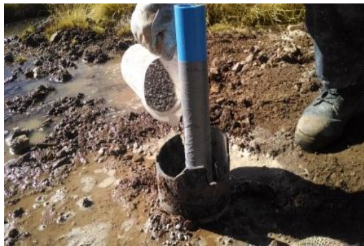
Figura 8: Operación de habilitación de la puntera
