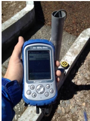
Figura 5: Instalación de Level troll
