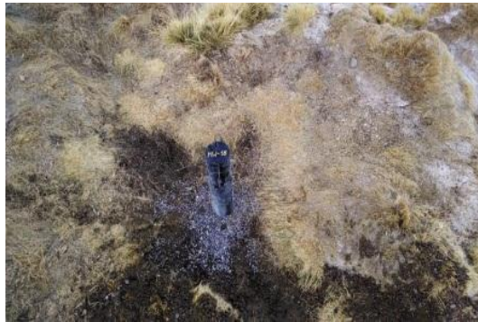
Figura 9: Colocación del brocal
