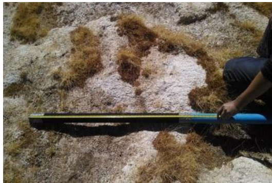
Figura 7: PVC ranurado con geotextil
