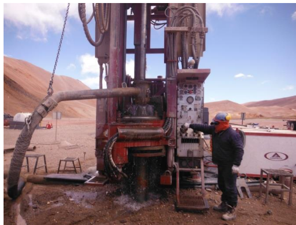
Figura 3: Perforación pozo de monitoreo
