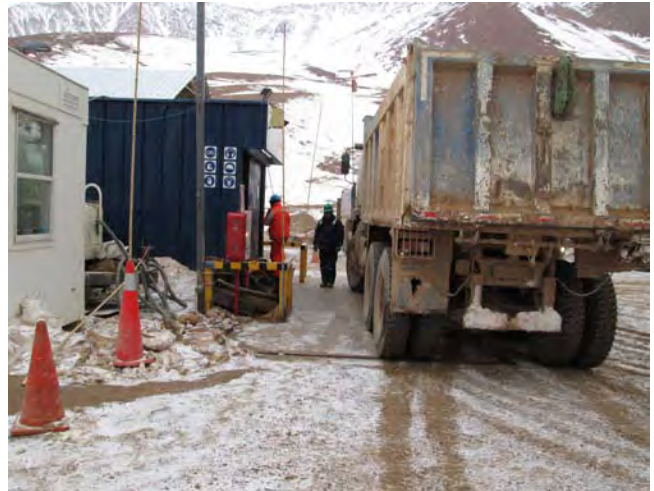
Fotografía N° 14 Detalle sistema de contención de derrames
