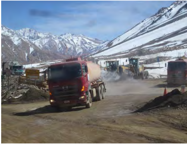
Fotografía N° 42 Humectación de caminos (04-09-2012)
