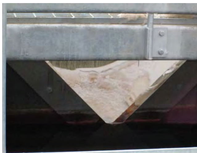
Fotografía N° 76 Sección para medir caudal (28-06-2012)
