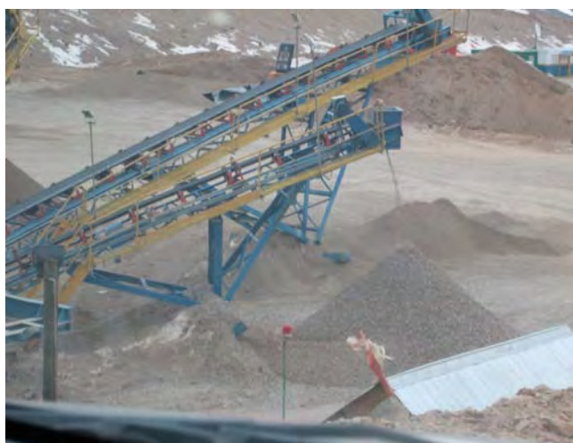
Fotografía N°97 Funcionamiento planta de áridos (28-06-2012)
