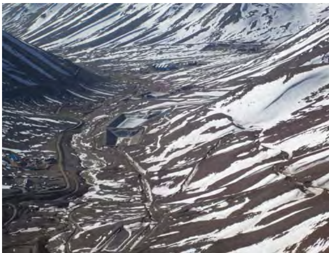
Fotografía N° 83 Piscinas de aguas de contacto (04-09-2012)
