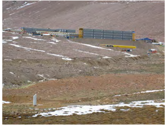
Fotografía N° 72 Vista estación NEV-3 (05-09-2012)
