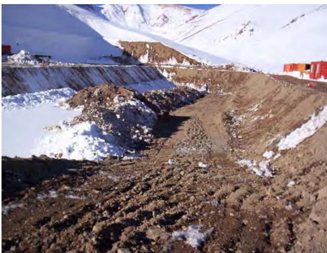
Fotografía N° 3 Vista de la zanja 2 destinada a RINP (31-05-2012)
