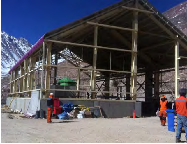
Fotografía N° 19 Vista construcción incinerador (04-09-2012)
