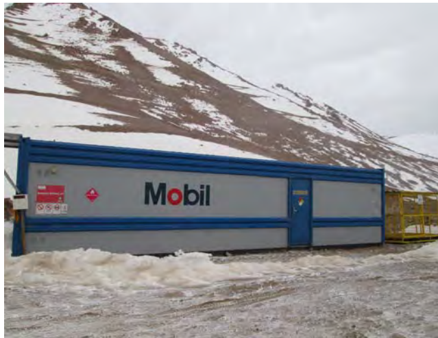
Fotografía N° 31 Bodega de Almacenamiento Vía limpia (29-06-2012)
