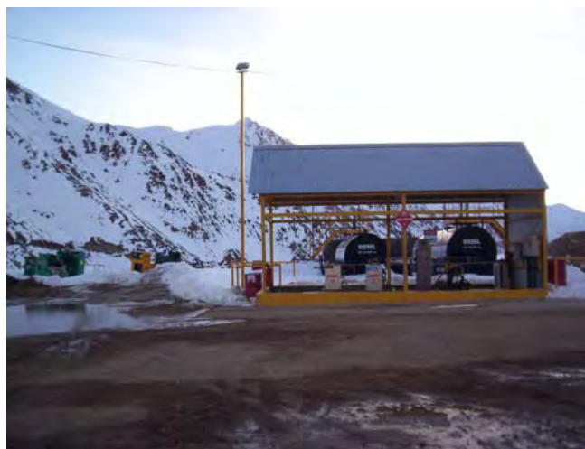
Fotografía N° 11 Vista Estación Servicio Barriales (31-05-2012)
