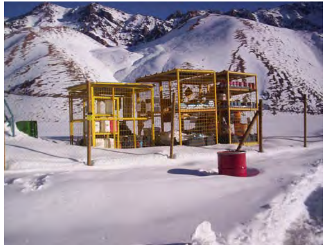
Fotografía N° 8 Vista de acopio RIP (31-05-2012)
