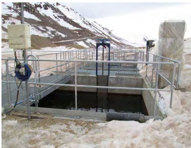
Fotografía N° 75 Cámara de restitución (28-06-2012)
