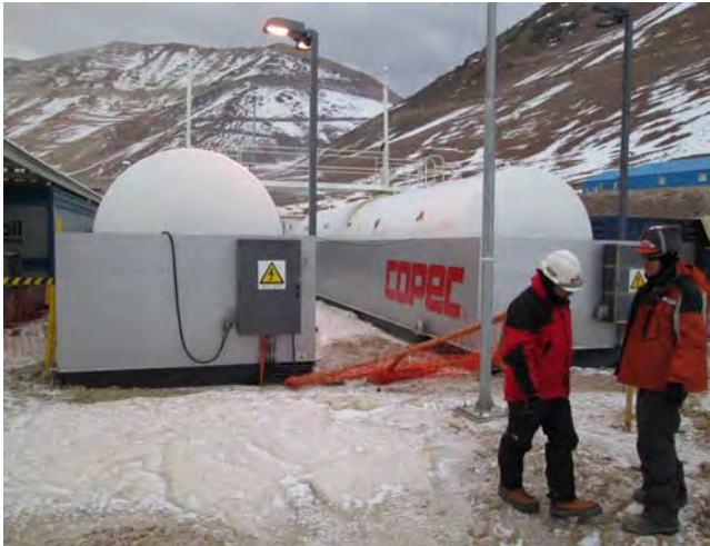
Fotografía N° 13 Vista Estación Servicio Consorcio (29-06-2012)
