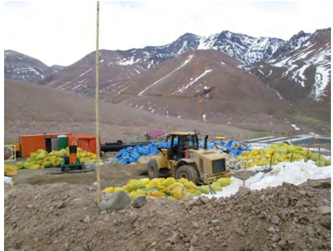
Fotografía N° 6 Vista patio salvataje (05-09-2012)
