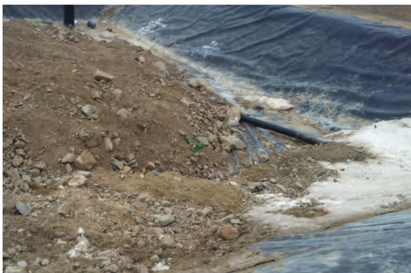
Figura N°96, trinchera de residuos en uso.
