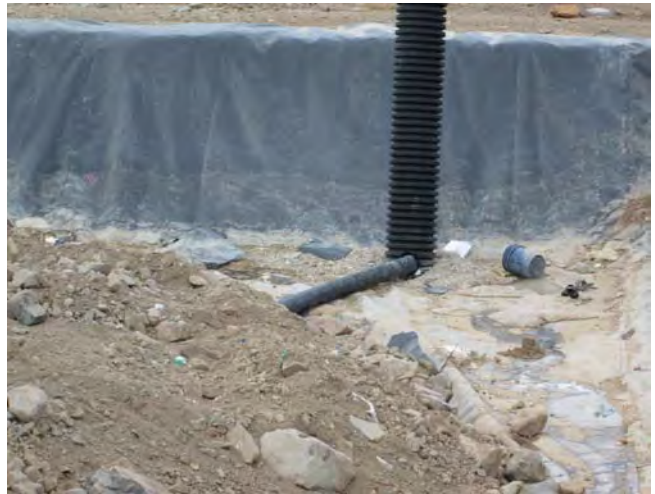
Fotografía N° 2 Vista de cobertura en a RD (05-09-2012)
