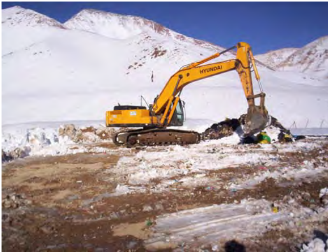
Fotografía N° 1 Vista de la compactación de RD (31-05-2012)
