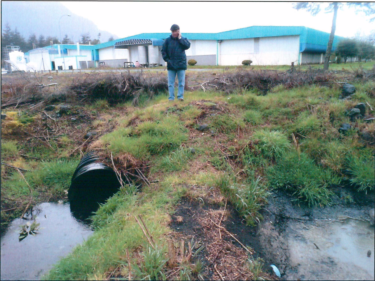
Fotografía 3. Punto de descarga. A la derecha RIL descargado; a la izquierda agua limpia. La conducción fue por la tubería subterránea de conducción de agua sobrante del pozo 1.
