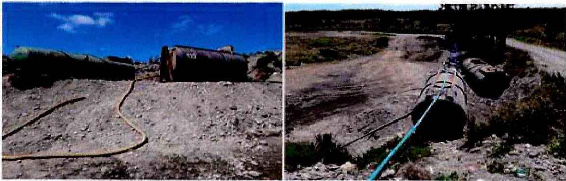
138. Posteriormente, estos estanques de acopio son vaciados por gravedad, para, finalmente, realizar la disposición de estos lixiviados en el estanque del sistema de evaporación, el cual se ilustra en la siguiente fotografía.
