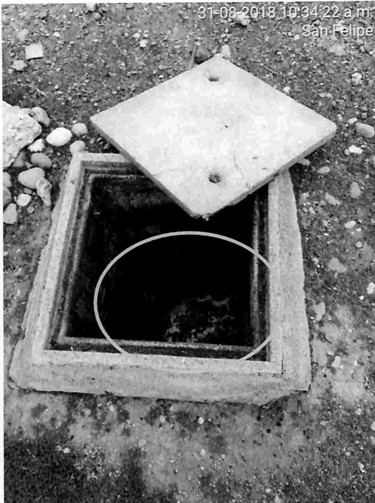
Imagen 1: cámara de infiltración sellada con mortero de secado rápido
