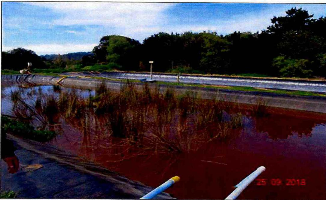
**Figura 1 Planta de Tratamiento de Líquidos Percolados – Filtros Palustres**
