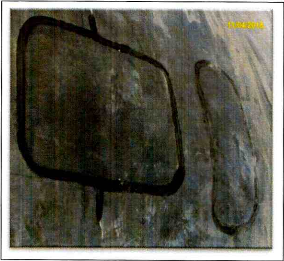
Imagen 3. Reparación de la geomembrana
