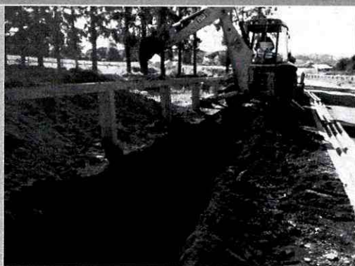
Fig.31. Excavaciones asociadas al ducto eléctrico sector calle N° 5. 23.04.2018
