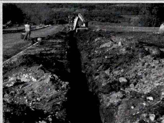
Fig.25. Excavaciones asociadas al ducto eléctrico calle N5
