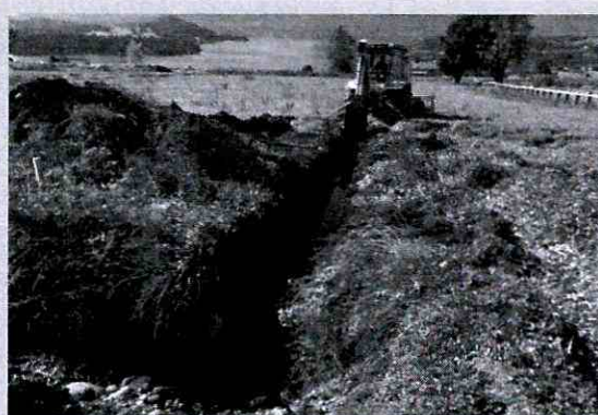
Fig.11 Excavaciones asociadas al agua potable
