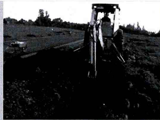
Fig.48. Trabajos agua lluvia y potable asociados a calle N° 1.
