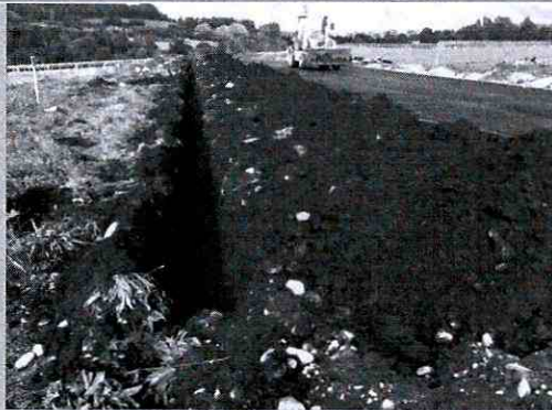
Fig.49. Trabajos agua lluvia y potable asociados a calle N° 1.
