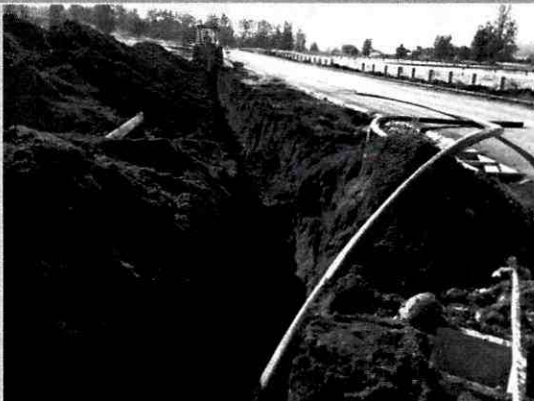
Fig.26. Excavaciones asociadas al ducto eléctrico calle N° 5
