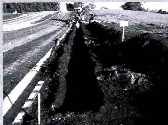
Fig.8 Trabajos asociados a los ductos de agua potable y eléctrico de la calle N° 1
