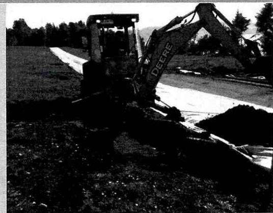
Fig.11 Trabajos asociados a los ductos de agua potable y eléctrico de la calle N° 1
