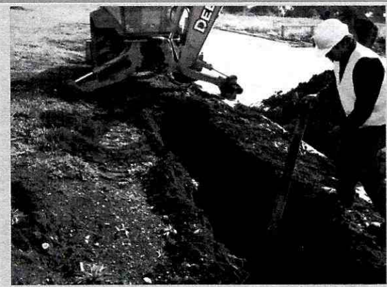
Fig.12. Trabajos asociados a los ductos de agua potable y eléctrico de la calle N° 1
