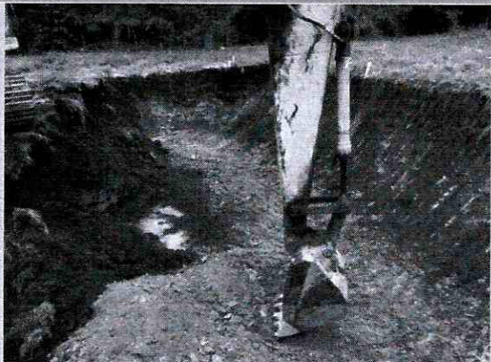
Fig.19. Excavaciones asociada al estanque de agua potable sector oficinas.
