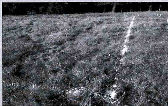
Fig. 4. Trazado e inicio de los trabajos de excavación asociados al estanque de agua potable del proyecto
