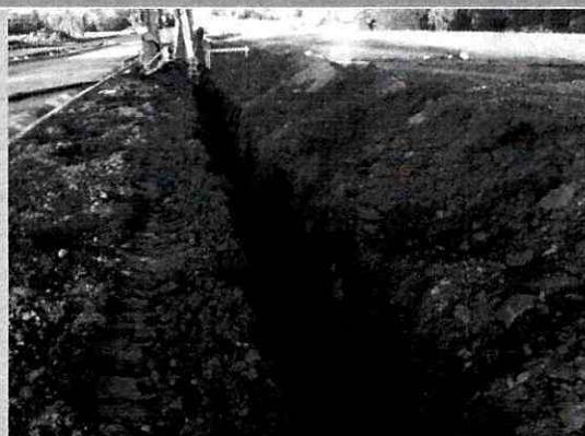
Fig.23. Excavaciones asociadas al ducto eléctrico calle N5
