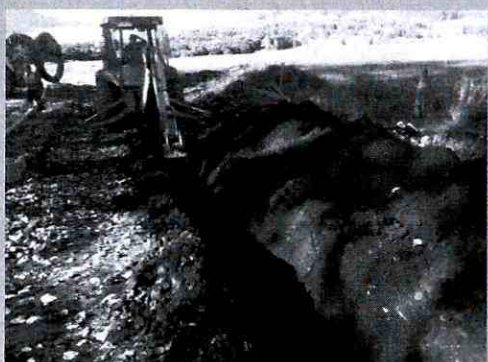
Fig.39. Excavación asociada al ducto de agua potable calle N° 1.
