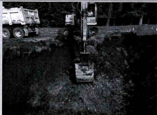
Fig.20. Excavaciones asociada al estanque de agua potable sector oficinas.
