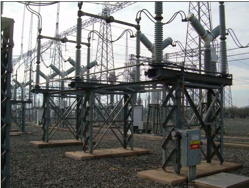
Fotografía 3. Desconector (89 JS-2) - Merlin Gerin - Paño Seccionador S/E Polpaico.
