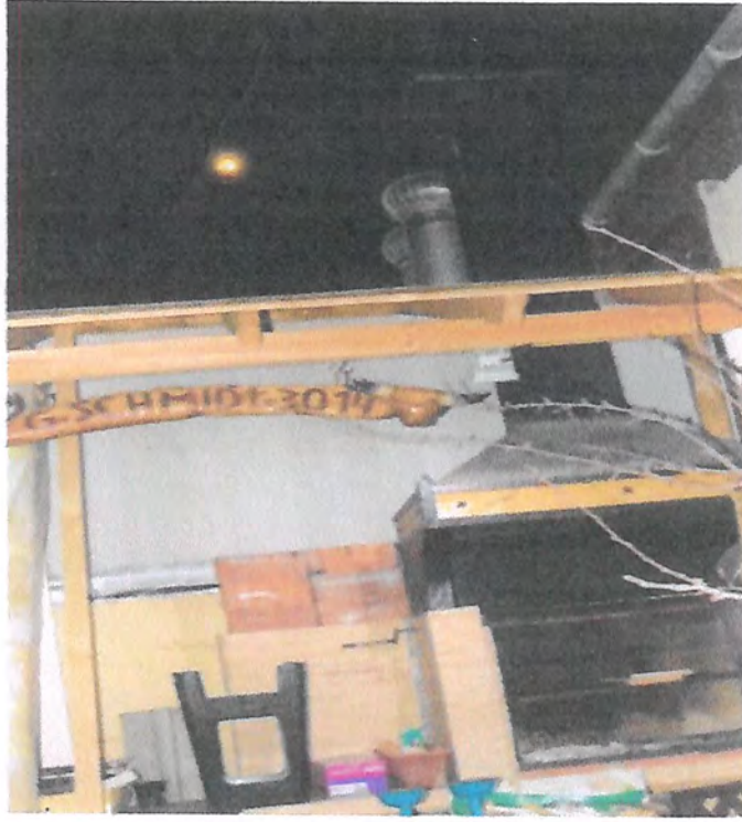
FOTO N° 11: SECTOR QUINCHO CASA VECINA
