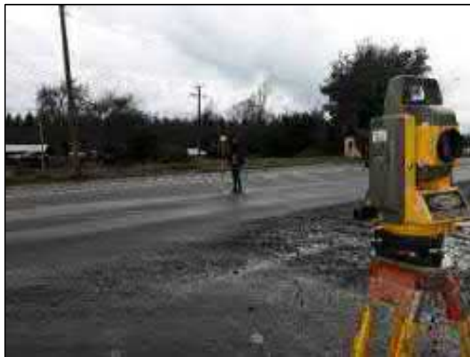
Fotografía 3: Realización de levantamiento mediante estación total
