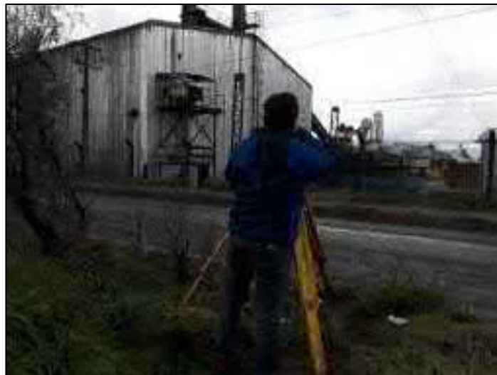
Fotografía 1: Realización de levantamiento mediante estación total.
