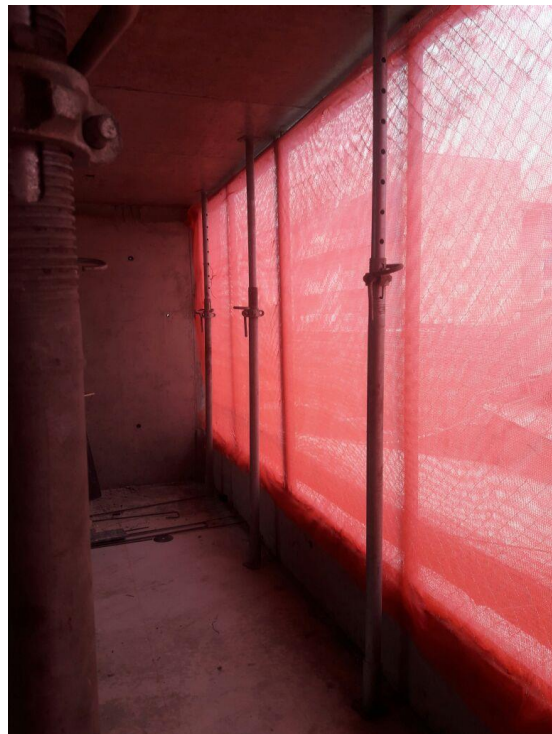
FOTOGRAFIA N°2 SE INSTALA PANTALLAS PROTECTORAS PISO TERCERO
