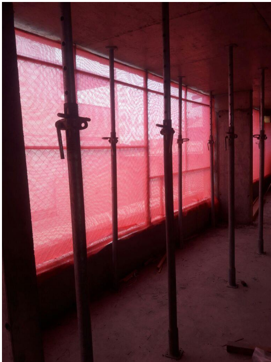
FOTOGRAFIA N°2 SE INSTALA PANTALLAS PROTECTORAS PISO TERCERO
