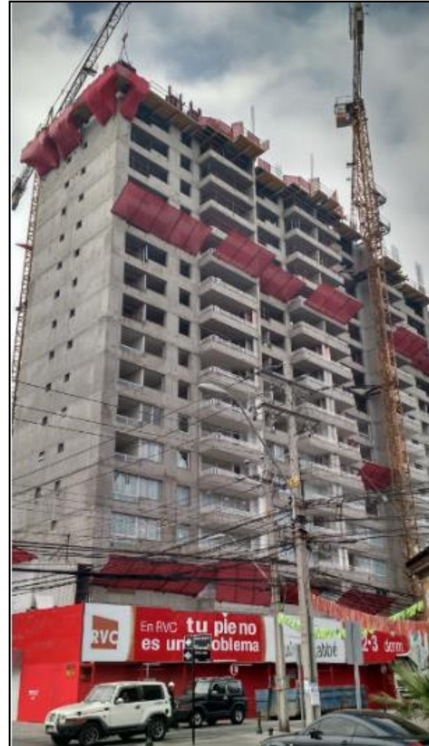
Vista Exterior. Esquina Obispo Labbé-Bulnes
