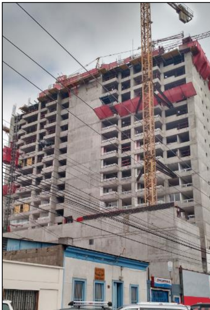
Vista Exterior. Esquina Bulnes
