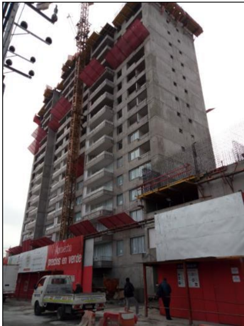
Vista Exterior. Portón Calle Obispo Labbé
