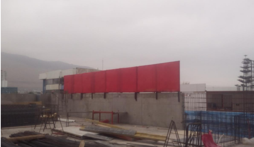
FOTOGRAFIA N°1 SE INSTALA PANTALLAS PROTECTORAS PISO CUARTO
