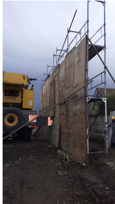
Figura 9. Pantalla acústica instalada a 1 m aprox. de grúa en posición cercano al punto receptor 1.
