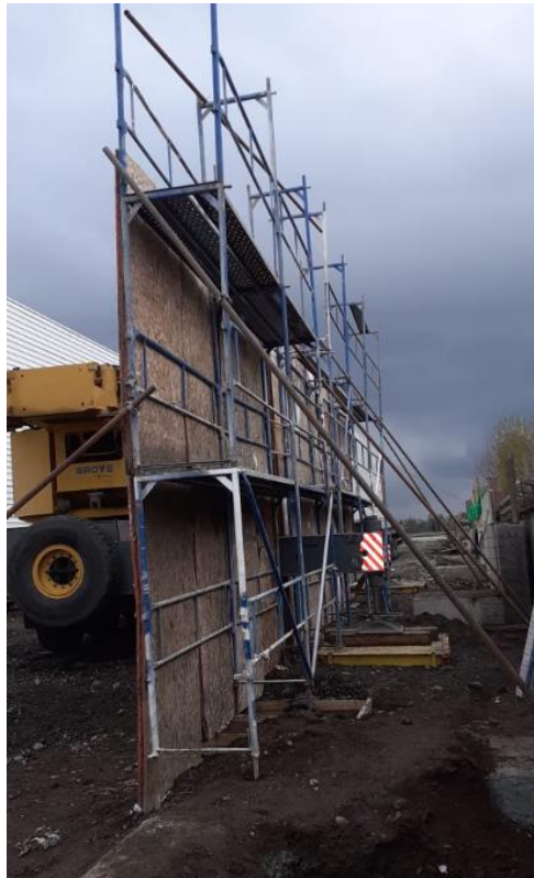
IMAGEN N°5 REGISTRO DE MURO ACUSTICO SECTOR CONTIGUO A VECINOS
