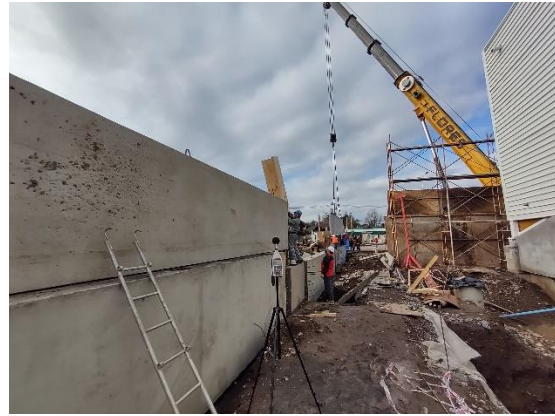
Figura 13. Pantalla acústica instalada a 3 m aprox. de grúa en posición cercano al punto receptor 2.
