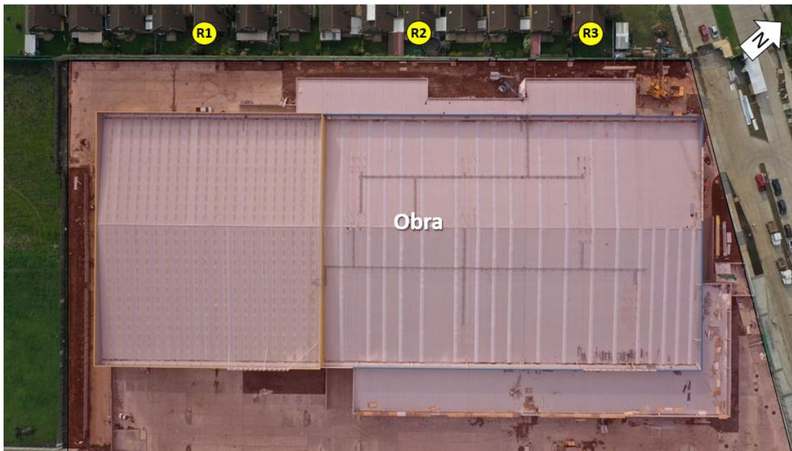
Fig. 1: Emplazamiento de la Obra, y ubicación de puntos receptores.
