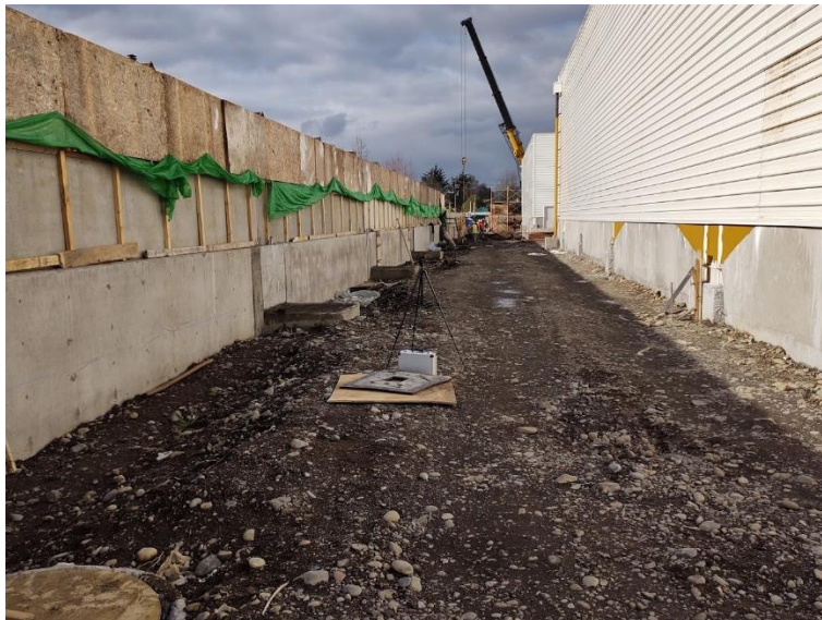
Fig. 17: Panel acústico sobre muro perimetral.
