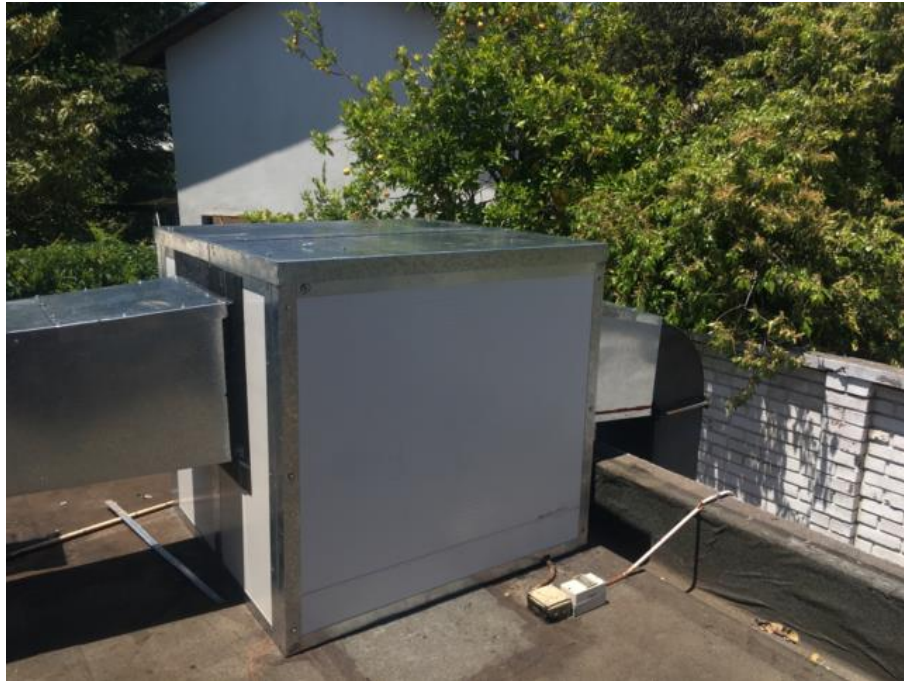
Figura 2 VEX CVTT-15/15—1,5HP 650 RPM
