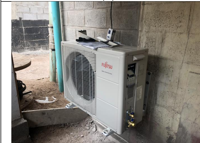
Instalacion de unidad condensadora
