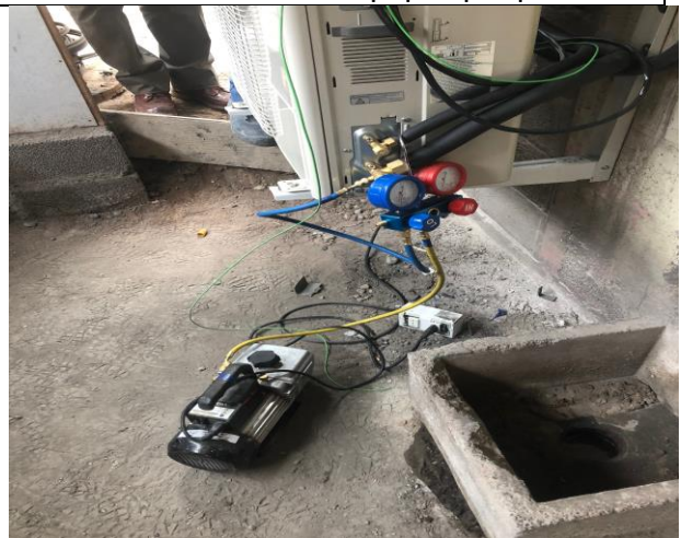
Vacío de circuito de refrigeración
