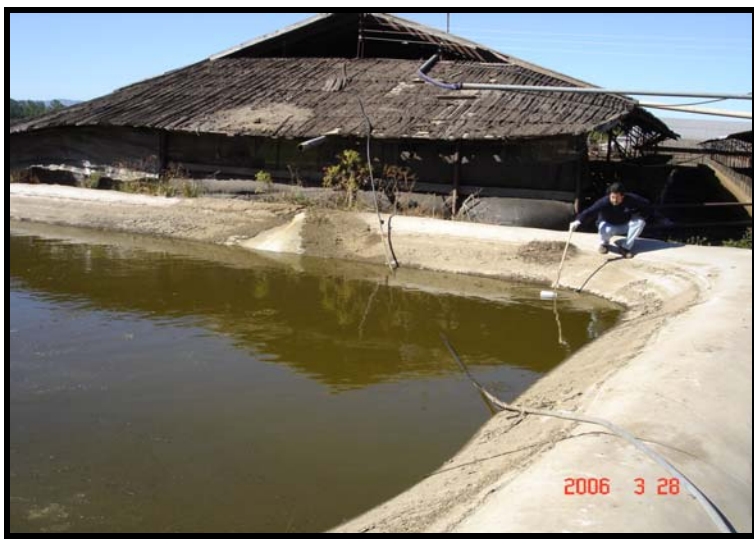
Fotografía 13.- Laguna de acumulación de purines, al fondo patios de alimentación. Sector Angol IX Región.
