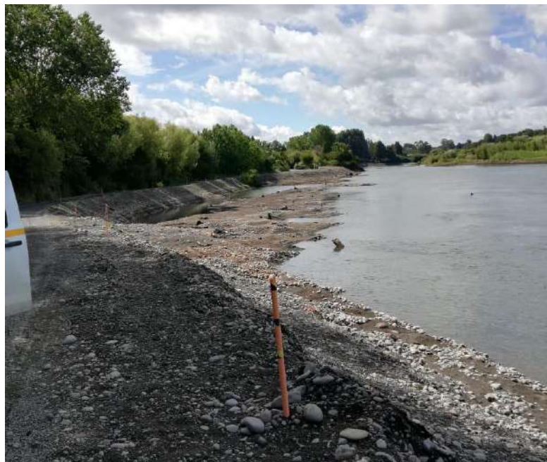
Figura 3. Terraplenes a remover Fuente. DSS S.A.
