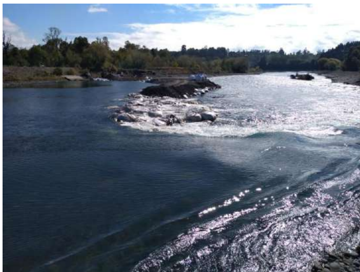
Figura 16 Relleno construido por la piscicultura visto desde ribera derecha hacia aguas abajo
