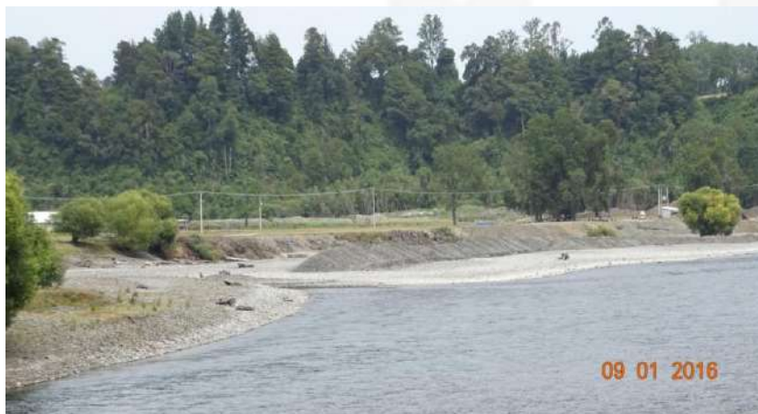
Fotografía N° 5 – Formación de pretil.
