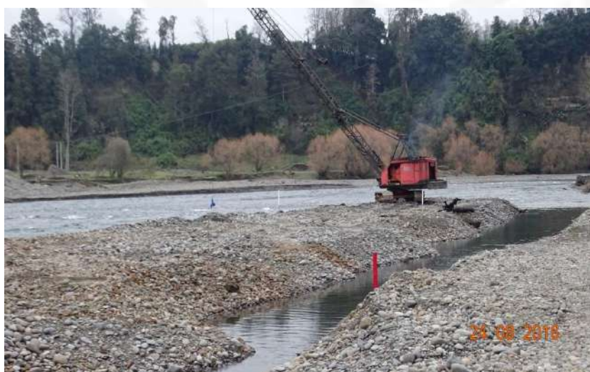
Fotografía N° 2 – Faenas de extracción aproximadamente en metraje 400 al 600.
