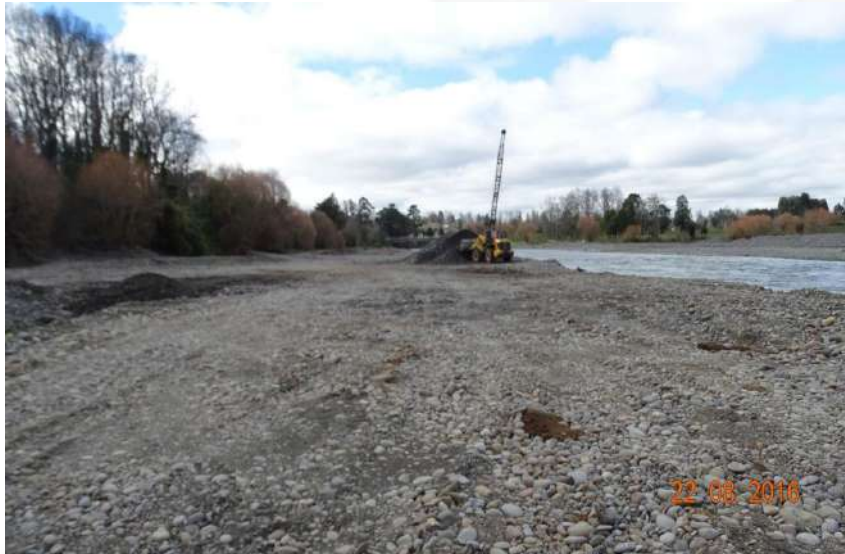
Fotografía N° 3 – Faenas de extracción aproximadamente en metraje 500 al 700.
