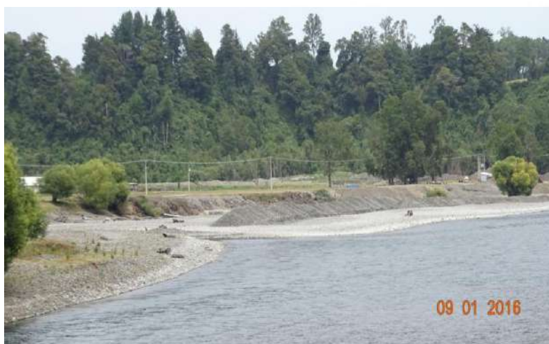
Fotografía N° 5 – Formación de pretil.
