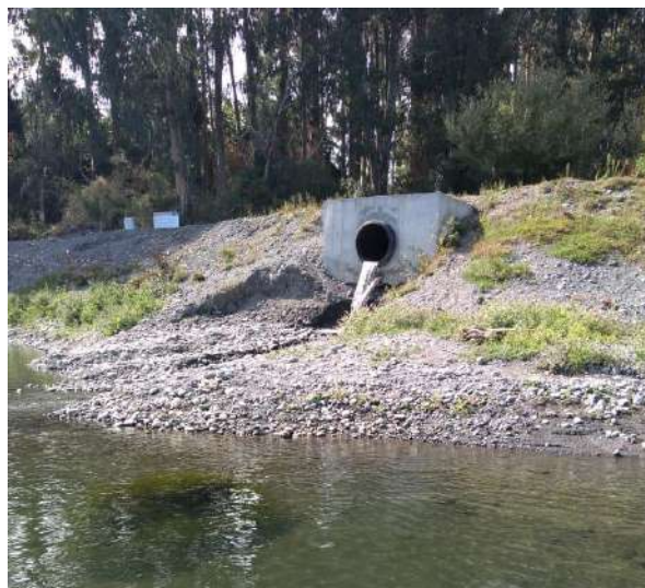
Figura 19 Obra de descarga piscicultura Humboldt Fuente: DSS S.A.
