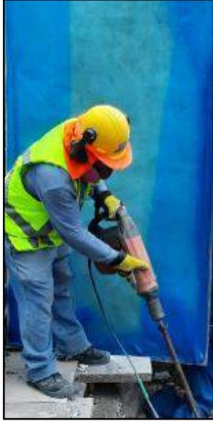
Fig. 1 – Trabajador utilizando biombo acústico.
