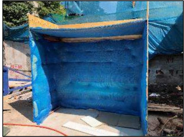
Fig. 2 – Biombo acústico para trabajos exteriores
