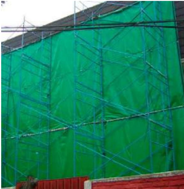
Figura 6. Instalación de Barrera Acústica Flexible (BAF) de Sonoflex.
