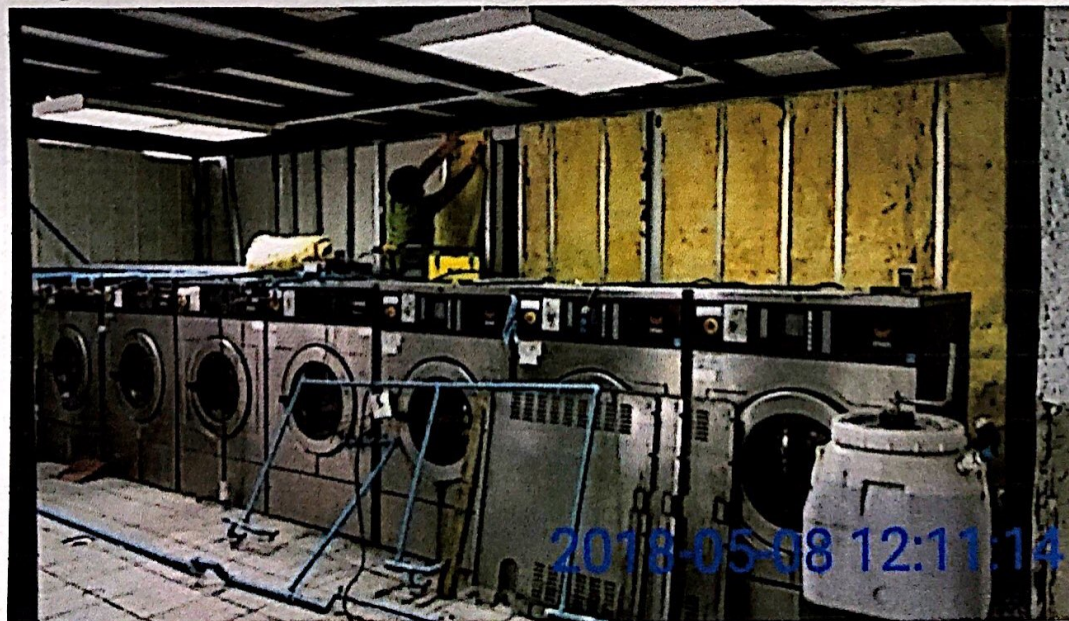
➤ Imagen N°6 Comienzo de Etapa de reforzamiento de muralla.
