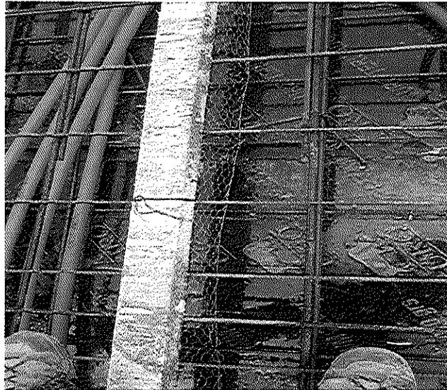
II.7- Utilización de moldaje ULMA, que es uno de los moldajes de mayor calidad en cuanto a la terminación de las superficies lo que permite minimizar faenas de desbaste o pulidos en las terminaciones.
