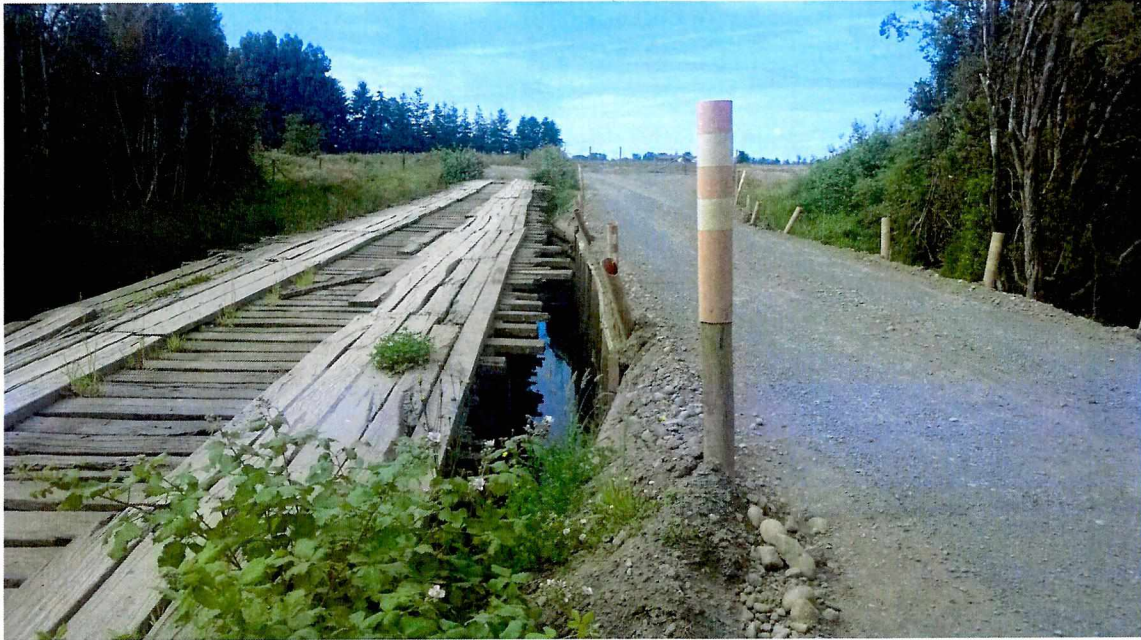
Imagen 2. Otra vista del estado actual del atravieso del Río Tijeral compuesto por cajones de hormigón y el puente de madera existente
