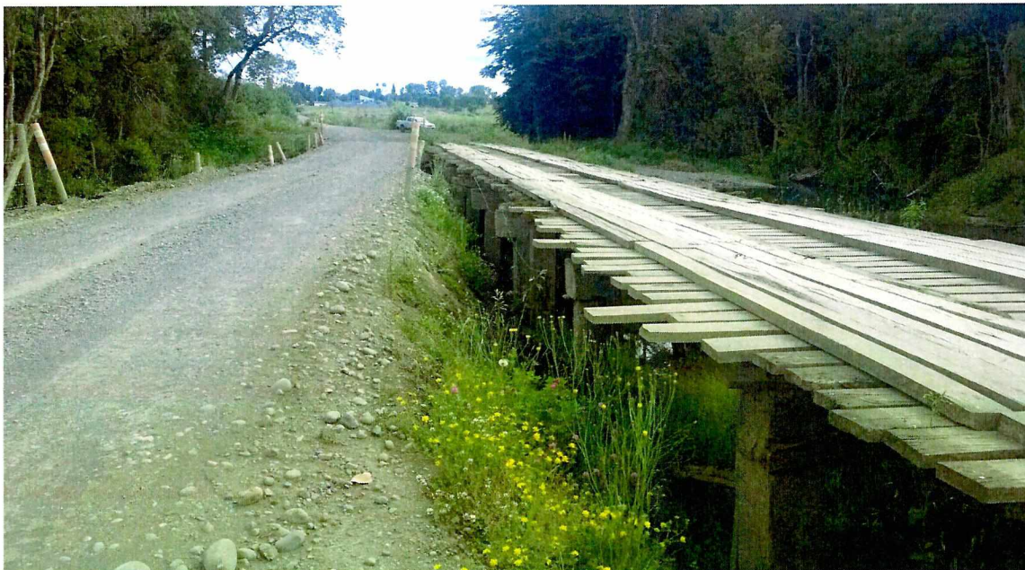
Imagen 1. Estado actual del Atravieso del Río Tijeral y puente de madera en malas condiciones para el cruce de vehículos
