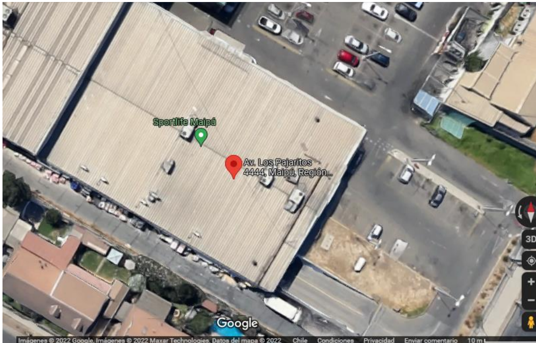
Ilustración 4 Imagen satelital de la sede, donde se aprecian las salidas de ventilación
