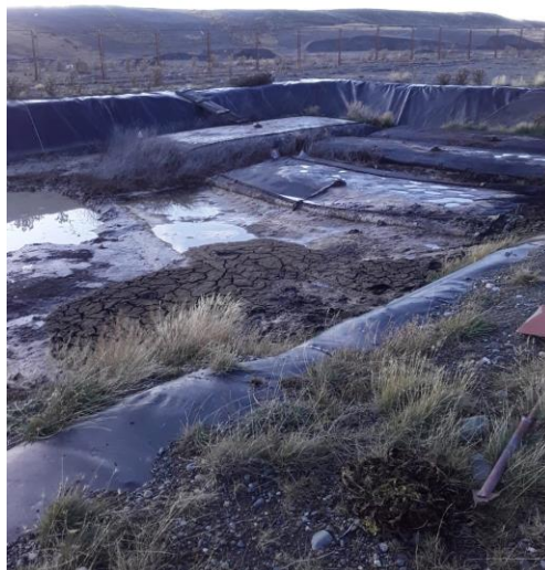
Figura 1. Registro Fotográfico pozo de lodos de Planta San Gregorio.
