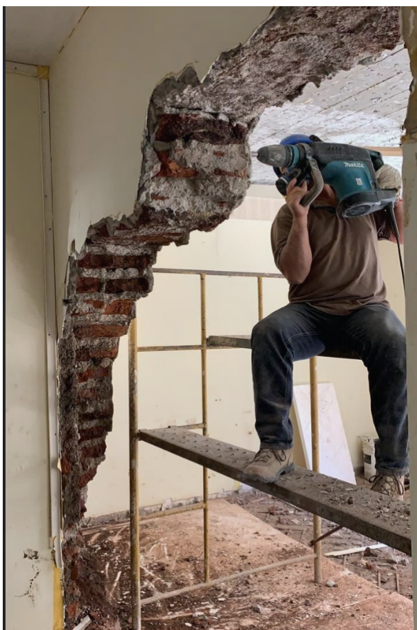
Figura 1: Operaciones realizadas en obra al momento de fiscalización.
